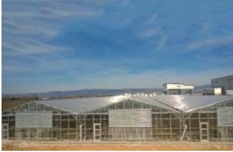
Şekil 2.32 Eskişehir OSB solar aktif çamur kurutma tesisinden bir görünüm (Arasya Atıksu Çözümleri, 2017)
