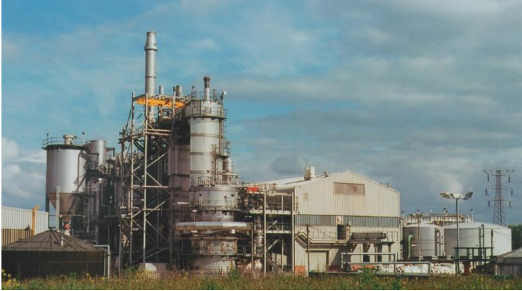
Şekil 3.5 İngiltere, Leeds, Knostrop atıksu arıtma tesisi yakma ünitesi (Abbott vd, 2003).
