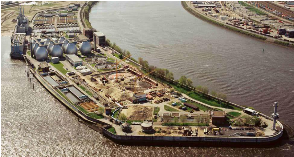
Şekil 3.4 Almanya,Hamburg-Köhlbrandhöft atıksu arıtma tesisi (Laurich, 2013).
