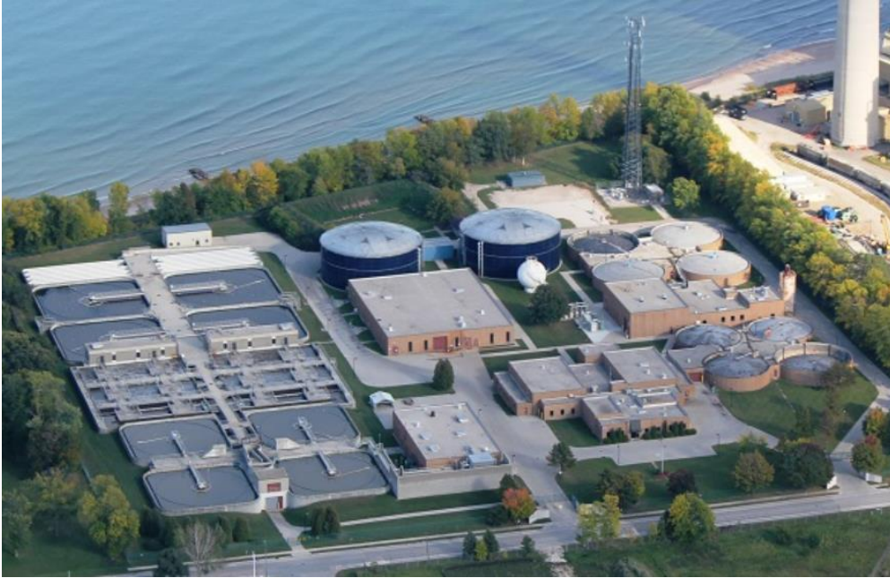
Şekil 3.14 ABD, Michigan Eyaleti'nde bulunan Sheboygan atıksu arıtma tesisi (Sheboygan AAT, 2017).
