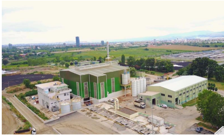
Şekil 3.1 Bursa Doğu Arıtma Tesisleri çamur yakma tesisi
