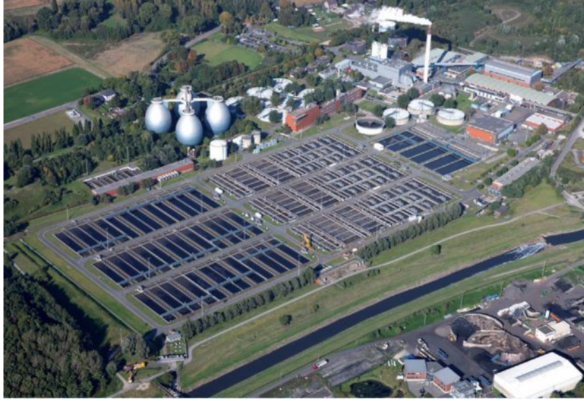
Şekil 3.3 Almanya, Bottrop atıksu arıtma tesisi (Emschergenossenschaft LV, 2016).
