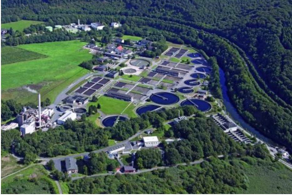
Şekil 3.16 Almanya Buchenhofen atıksu arıtma tesisi (Wupperverband, 2012).
