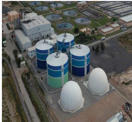
Şekil 3.12 Çiğli Atıksu Arıtma Tesisi (İZSU Faaliyet Raporu, 2016).
