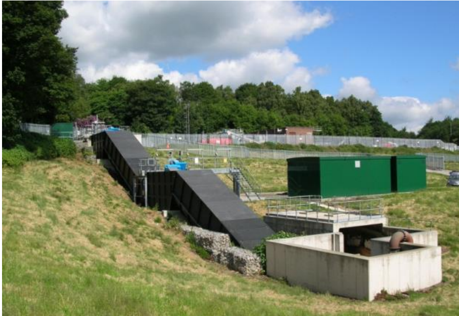
Şekil 3.20 İngiltere, Esholt Atıksu Arıtma Tesisinde Arşimet vidası (Spaan Babcock Ltd., 2010)
