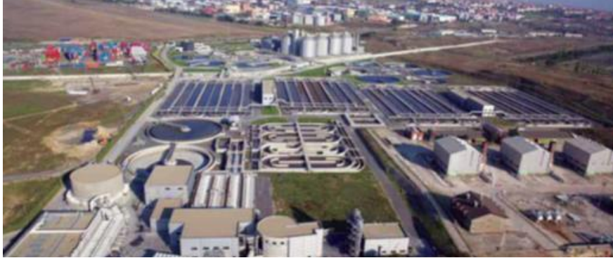
Şekil 3.11 Ambarlı İleri Biyolojik Atıksu Arıtma Tesisi (İSKİ Faaliyet Raporu,2016).
