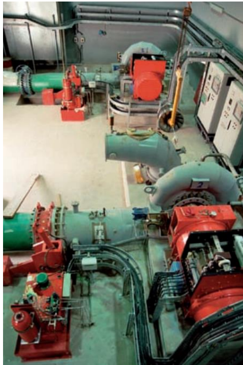
Şekil 3.19 Ürdün As Samra Atıksu Arıtma Tesisi, 2 Francis türbin (Bachelery, 2017).
