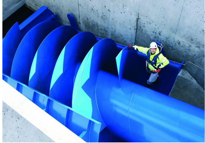
Şekil 3.17 Viyana Atıksu Arıtma Tesisinde bulunan Kaplan ve Arşimet türbinleri (Ebswien SterneE).
