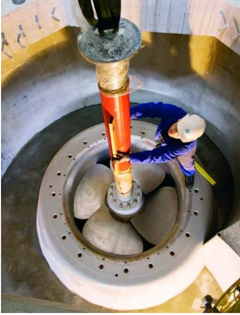
Şekil 3.17 Viyana Atıksu Arıtma Tesisinde bulunan Kaplan ve Arşimet türbinleri (Ebswien SterneE).
