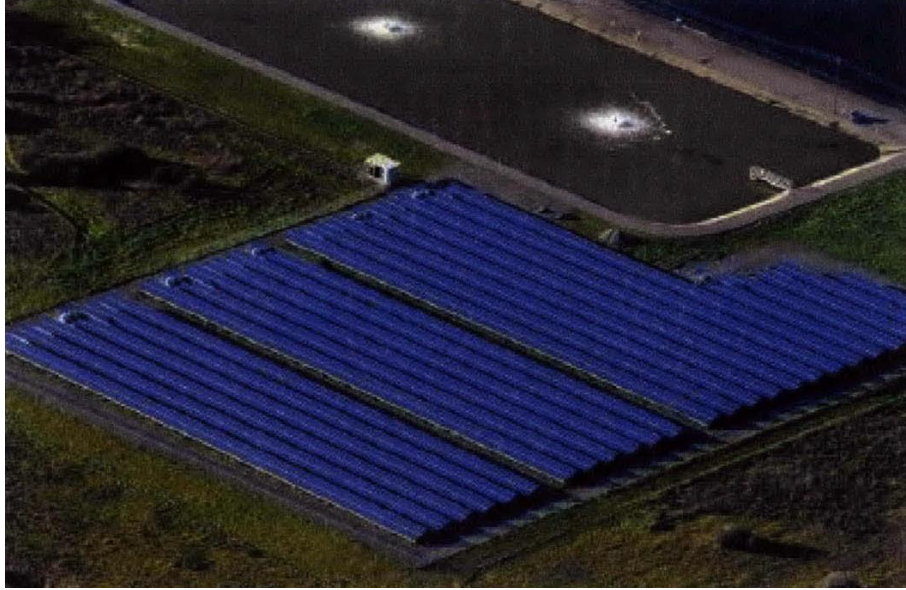
Şekil 3.30 ABD, Kaliforniya Oroville Atıksu Arıtma Tesisi güneş panelleri (Spellman, 2013)
