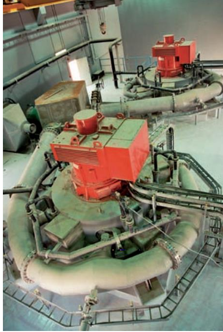
Şekil 3.18 Ürdün As Samra Atıksu Arıtma Tesisi, beş nozullu 2 Pelton türbin (Bachelery, 2017).
