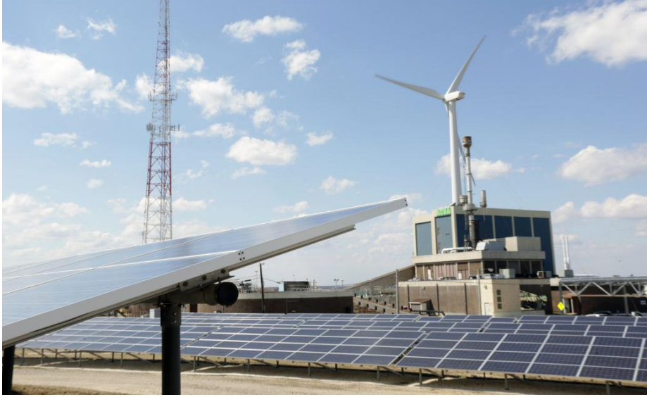
Şekil 3.29 ABD, Atlantik City atıksu arıtma tesisindeki güneş panelleri (Post, 2016)
