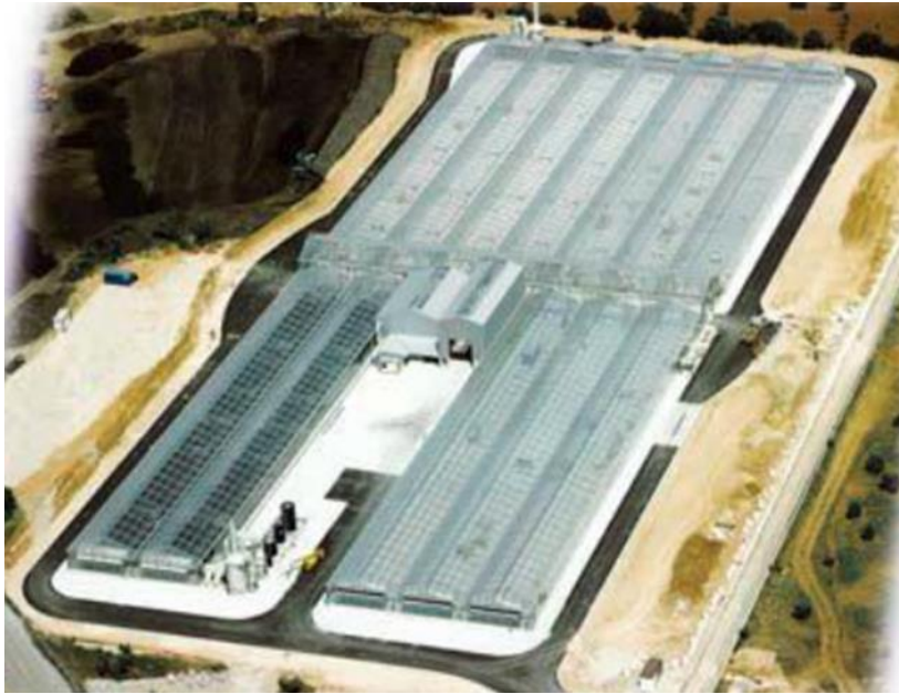
Şekil 2.30 İspanya'da bulunan solar çamur kurutma tesisi (Ritterbusch, 2012)
