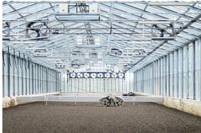
Şekil 3.28 Almanya-Bottrop atıksu arıtma tesisi güneşte kurutma (ATBEST Projesi, 2015)
