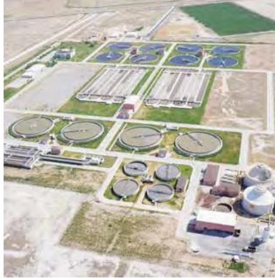
Şekil 3.8 Konya Kentsel Atıksu Arıtma Tesisi (KOSKİ Faaliyet Raporu, 2016).
