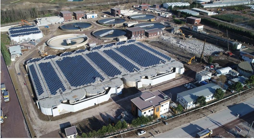
Şekil 3.26 Kullar AAT’de havuzların üzerine uygulanan GES panelleri
