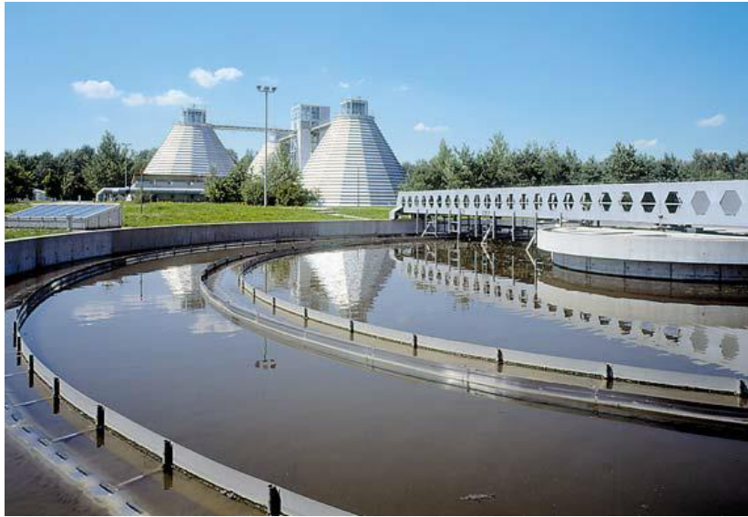
Şekil 3.13 Almanya Gut Marienhof atıksu arıtma tesisi (Münchener Stadtentwässerung, 2006).
