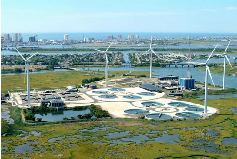
Şekil 3.23 ABD, Atlantik City’de bulunan ACUA (Atlantic City Utilities Authority) Atıksu Arıtma Tesis (Waugh, 2015)
