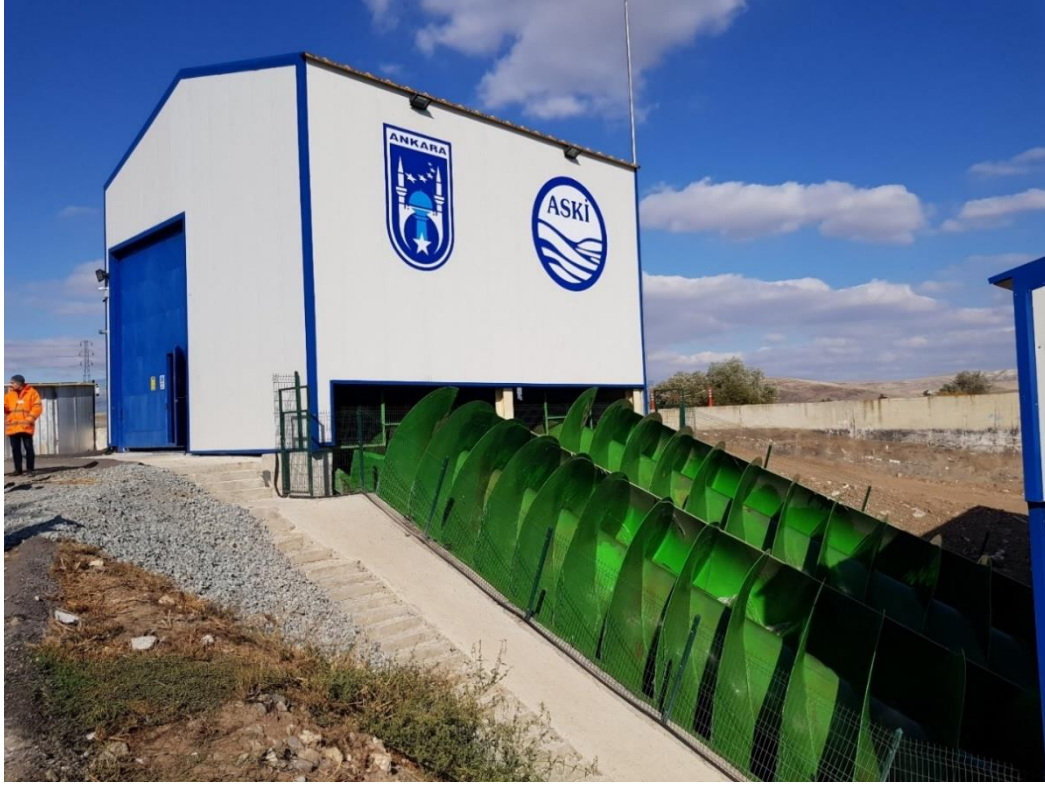
Şekil 3.15 Ankara Tatlar AAT deşarj noktasında bulunan 1 MW'lık Arşimet vidası
