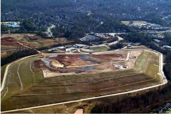
Şekil 3-4 Depolama sahası yüzey suyu drenajı
