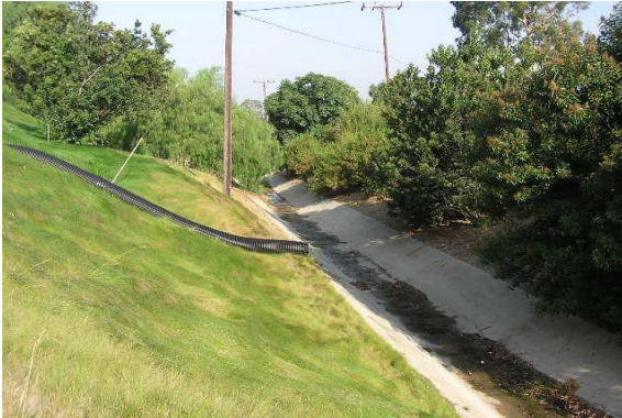
Şekil 3-5 Nihai kapama ve yağış sularının kontrolü
