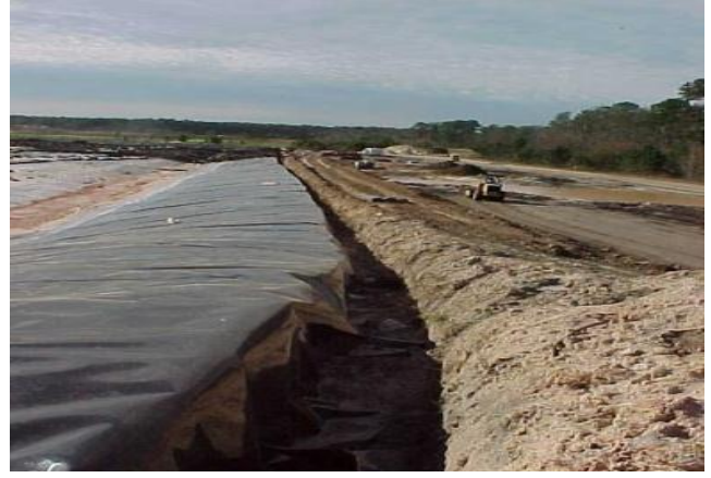
Şekil 3-2 Depolama sahası drenaj uygulaması
