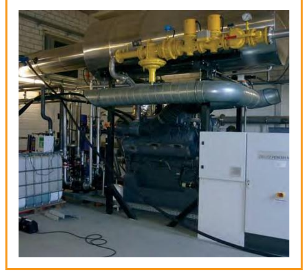
Şekil 6.8: Gaz kontrol hattı BHKW [DBFZ]
