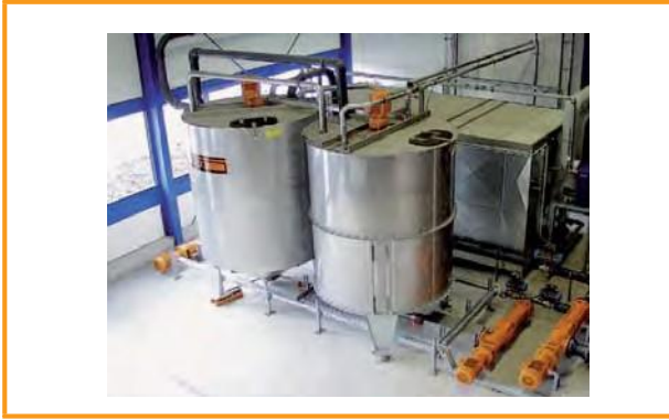
Şekil 3.10: Soğutmalı hijyenleştirme [TEWE Elektronik GmbH & Co. KG]
