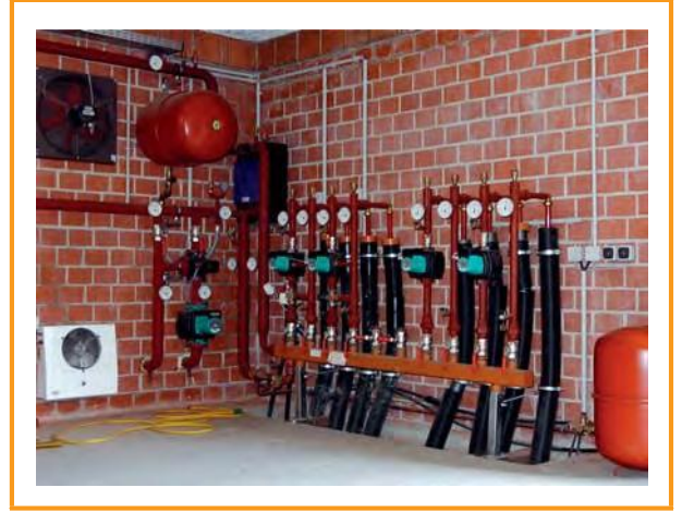
Şekil 6.7: Isı dağıtıcısı [MT-Energie-GmbH]
