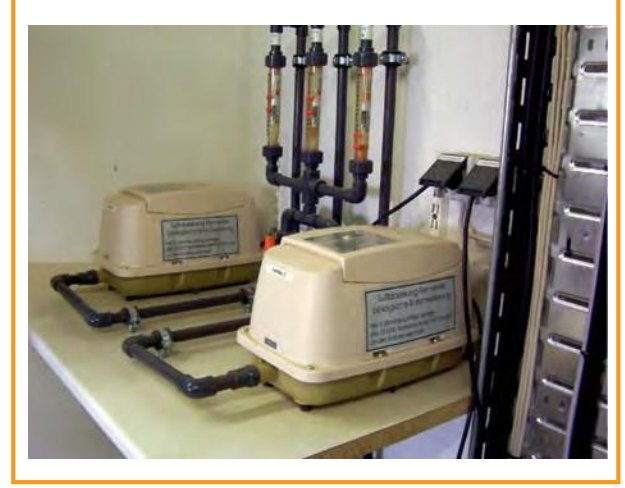
Şekil 6.1: Fermentörün gaz bölmesine hava üflenmesi için gaz düzenlemesi [DBFZ]
