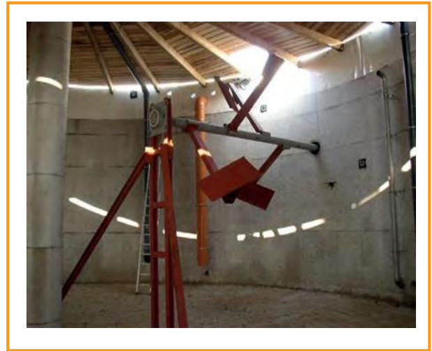
Şekil 3.34: Kanatlı karıştırıcı [PlanET GmbH]
