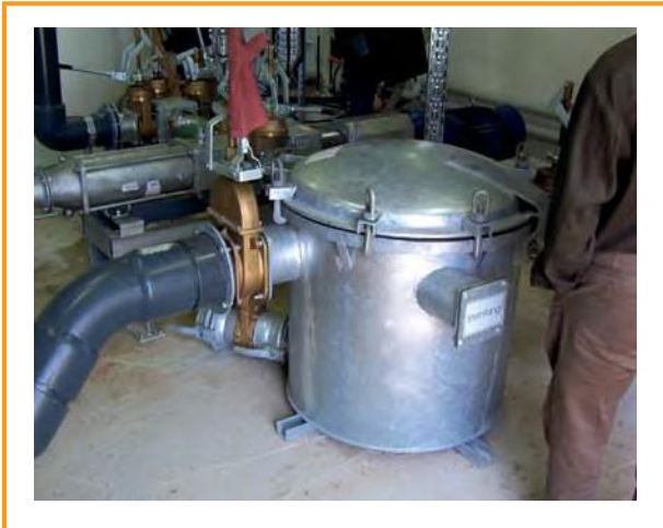
Şekil 3.5: Bir boru hattında ağır materyal tutucu [DBFZ]
