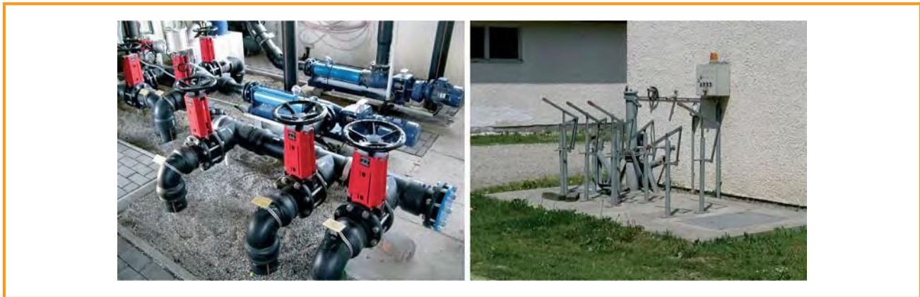
Şekil 3.20: Bir pompa istasyonunda boru hatları ve armatürler, kapatma sürgüleri [DBFZ]
