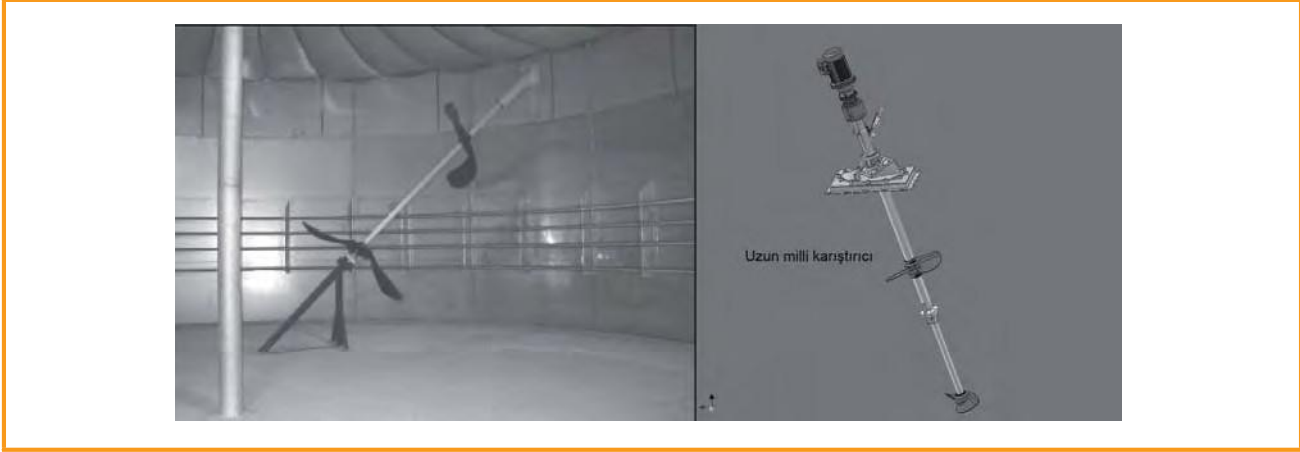
Şekil 3.32: Fermentör tabanında yatağı olan ve olmayan, iki karıştırma takımlı uzun akslı karıştırıcılar [WELTEC BIOPOWER GmbH; Grafik: Armatec FKM-Armaturen GmbH & Co. KG]
