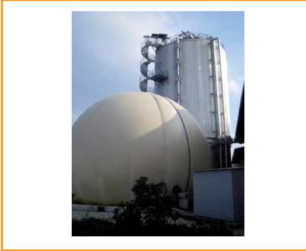
Şekil 3.40: Bağımsız çift membranlı depo örneği [Schüsseler, FNR]
