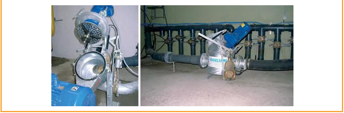
Şekil 3.8: Besleme hattında materyal parçalama (delikli diskli parçalayıcı) [Hugo Vogelsang Maschinenbau GmbH]
