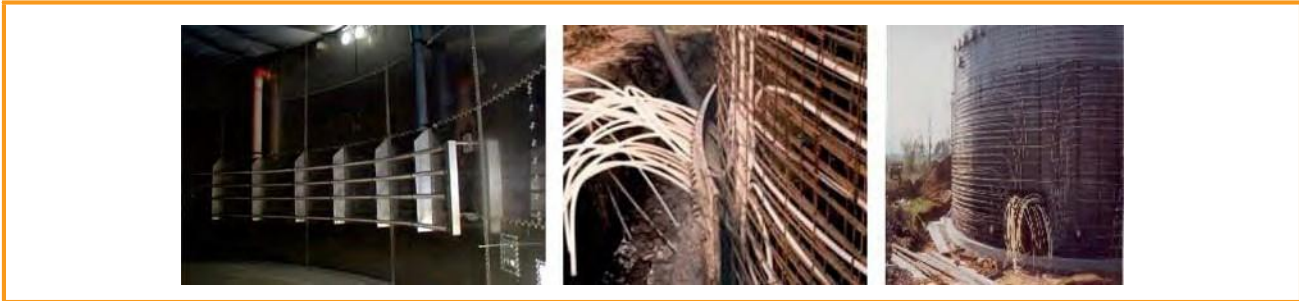
Şekil 3.37: Fermentöre döşenmiş paslanmaz çelik ısıtıcı borular (iç tarafta) (solda); fermentör duvarına ısıtıcı hortumların montajı (sağda) [Biogas Nord GmbH; PlanET Biogastechnik GmbH (sağ)]
