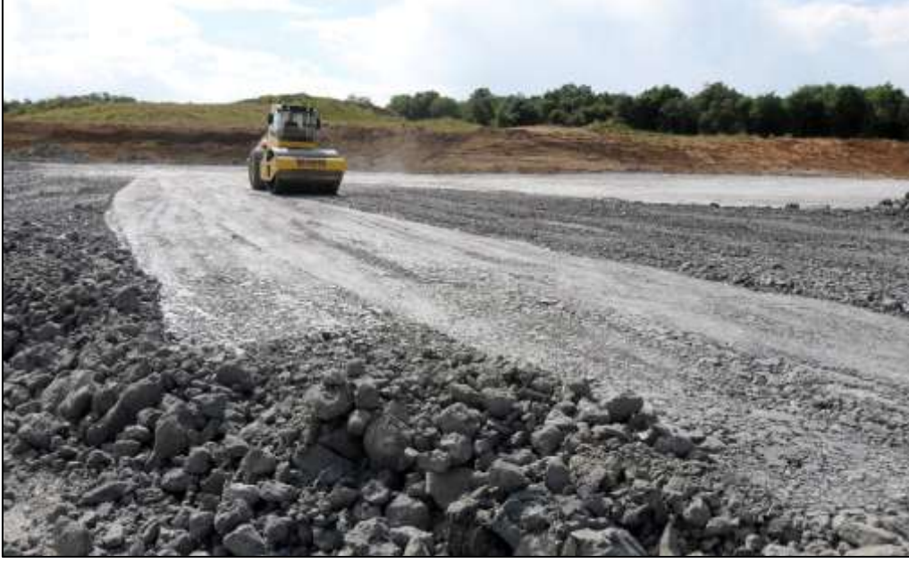
Resim 3: Kil Serimi ve Sıkıştırılması (Kil Geçirimsizlik Tabakasının Oluşturulması)
