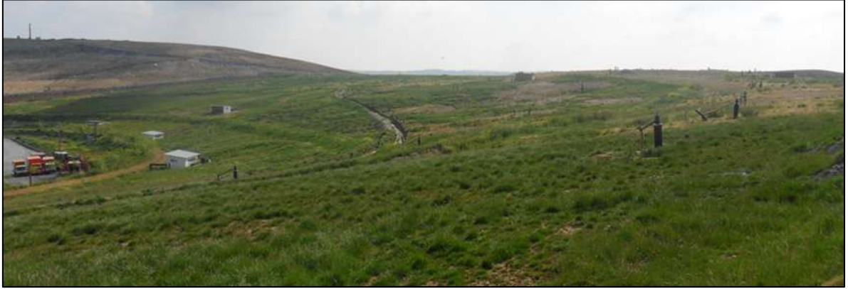
Resim 34: Nihai Örtü Drenajı
