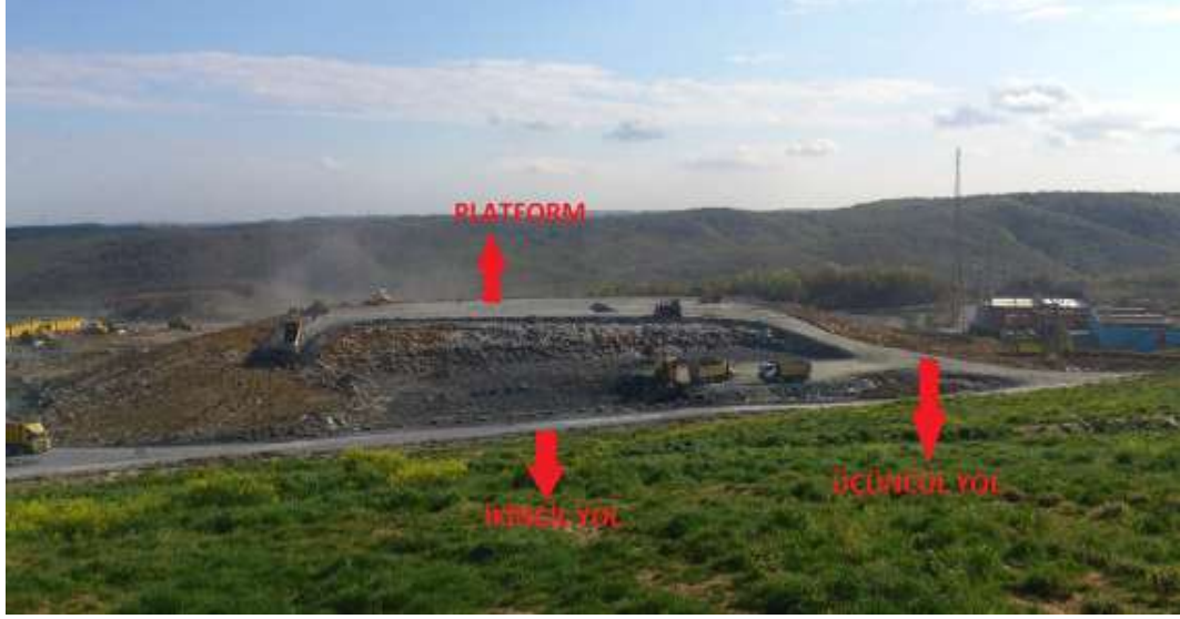
Resim 17. Tesis İçi Yollar ve Platform
