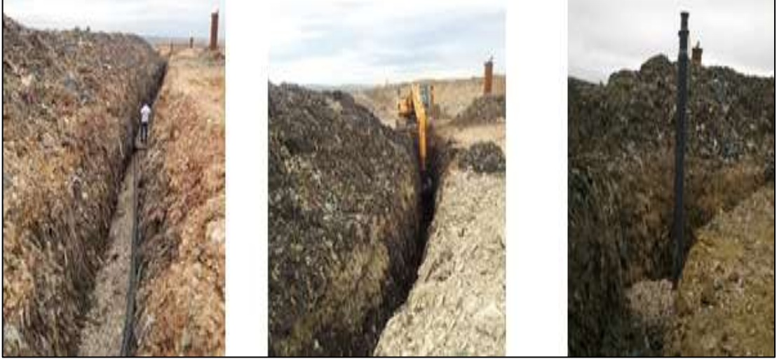
Resim 14: Yatay Gaz Toplama Sistemi
