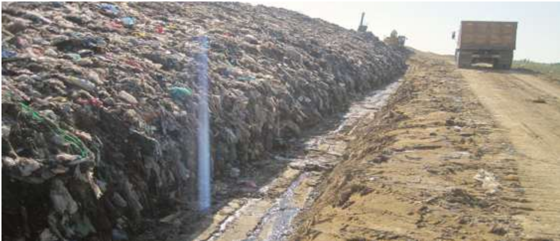
Resim 36: Yüzeye Çıkan Sızıntı Sularının Ana Drenaj Sistemine Bağlanması İçin Açılan Kanallar
