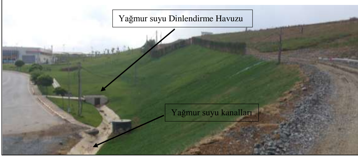
Resim 29: Yağmur Suyu Toplama Kanalları (V Kanalı)
