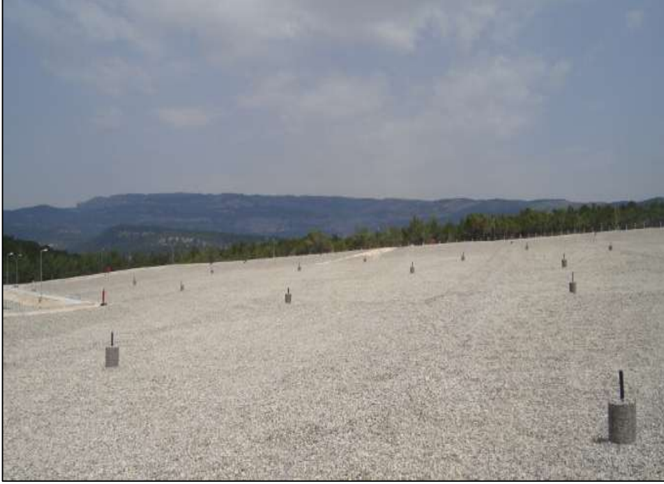
Resim 13: Depo Gazı Toplama Sistemi
