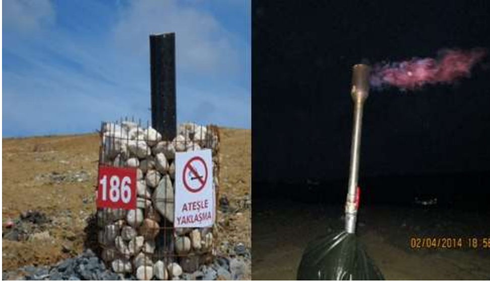
Resim 15: Gaz Toplama Bacası ve Meşale
