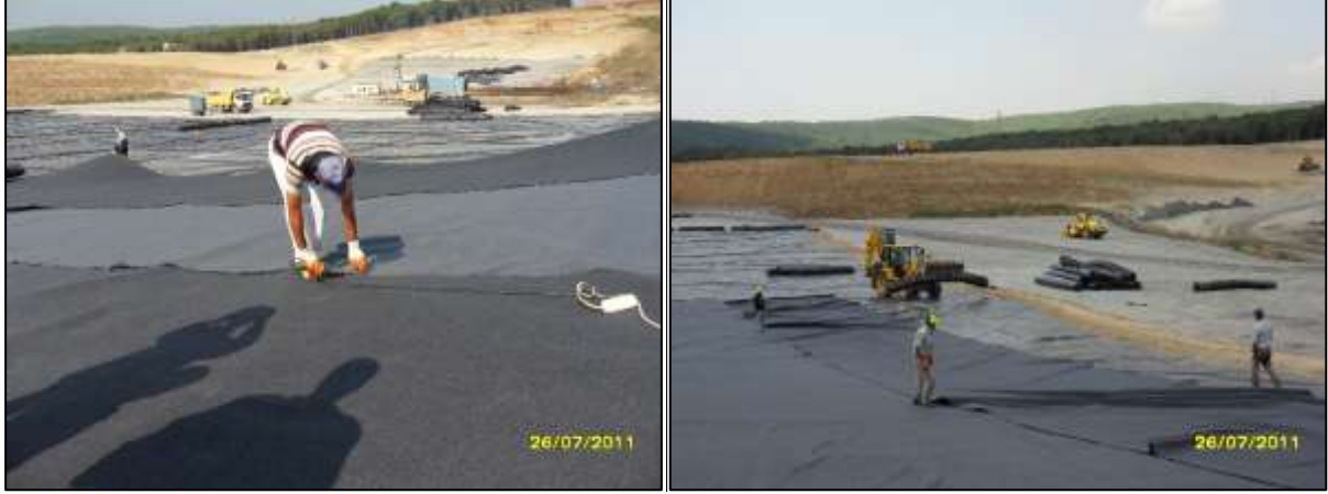
Resim 10: Jeotekstilin Serimi ve Jeotekstil Kaynak İşi
