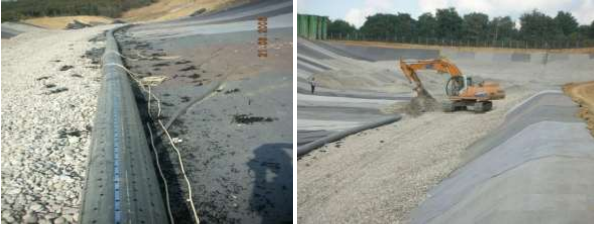
Resim 12: Sızıntı Suyu Drenaj Borusu Yerleştirilmesi
