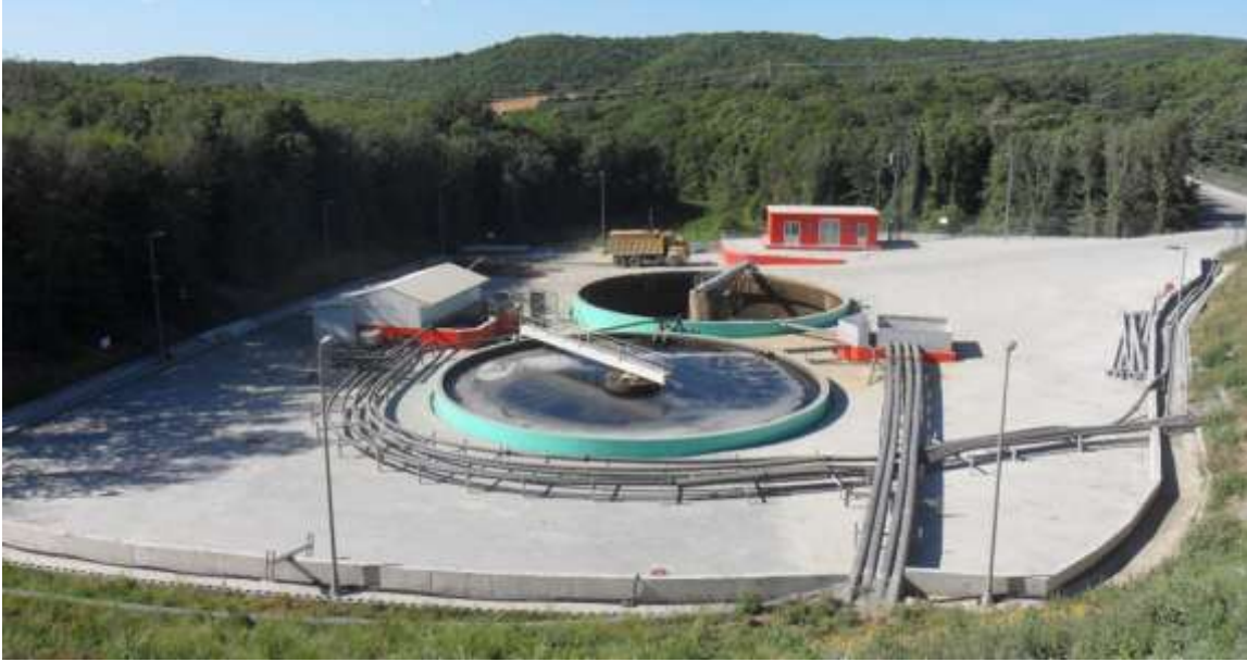
Resim 35: Sızıntı Suyu Toplama Havuzu
