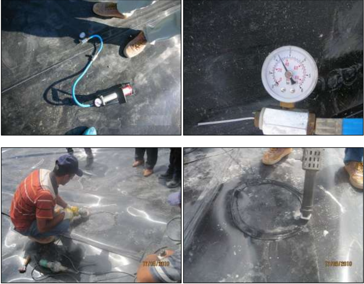
Resim 9: Hava Basınç Testi ve Füzyon Kaynağı ile Jeomembran Onarımı(R.D.)
