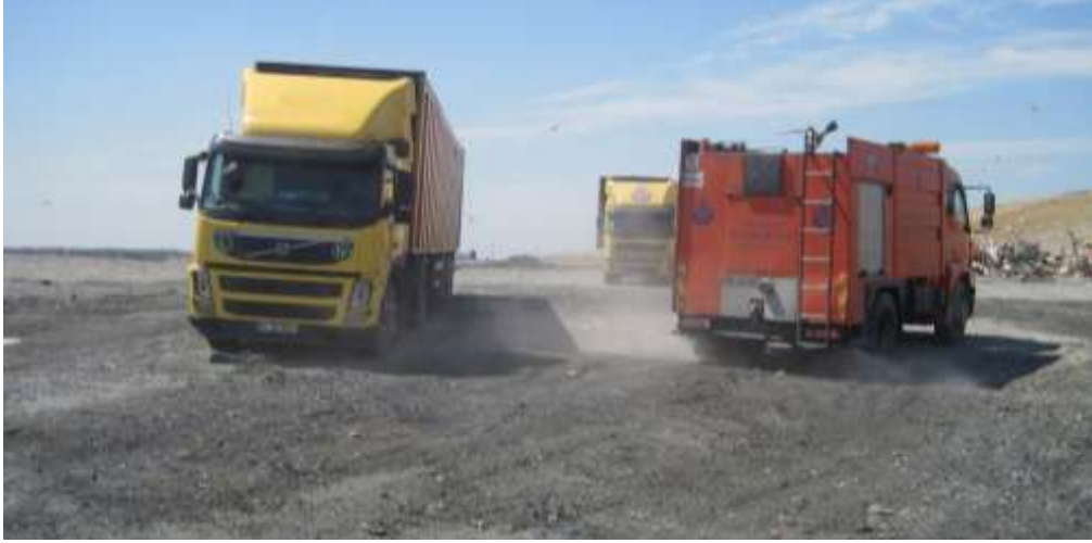
Resim 38:Sahada Toz Oluşumunu Önlemek İçin Saha İçi Yol ve Platformun Sulanması
