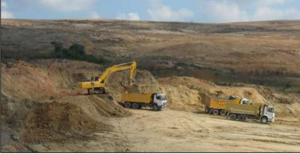
Resim 2: Hafriyat ve Saha Tesviye Çalışmaları
