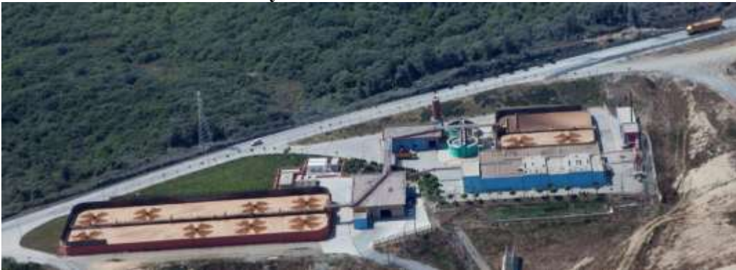
Resim 37: Sızıntı Suyu Arıtma Tesisi
