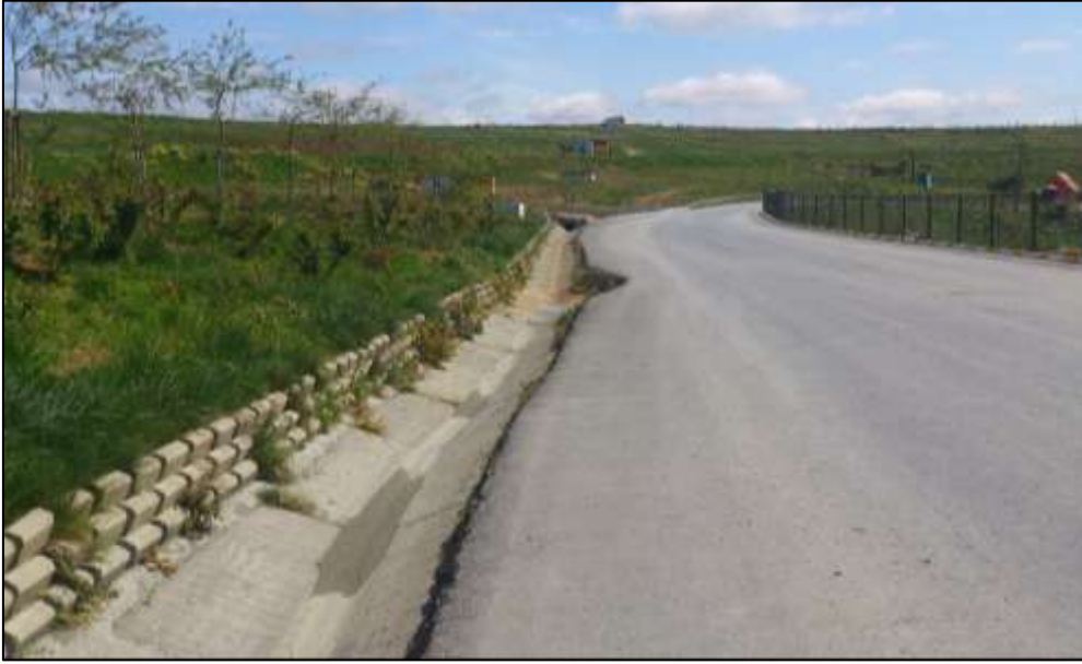
Resim 30: Birincil Drenaj Sistemi
