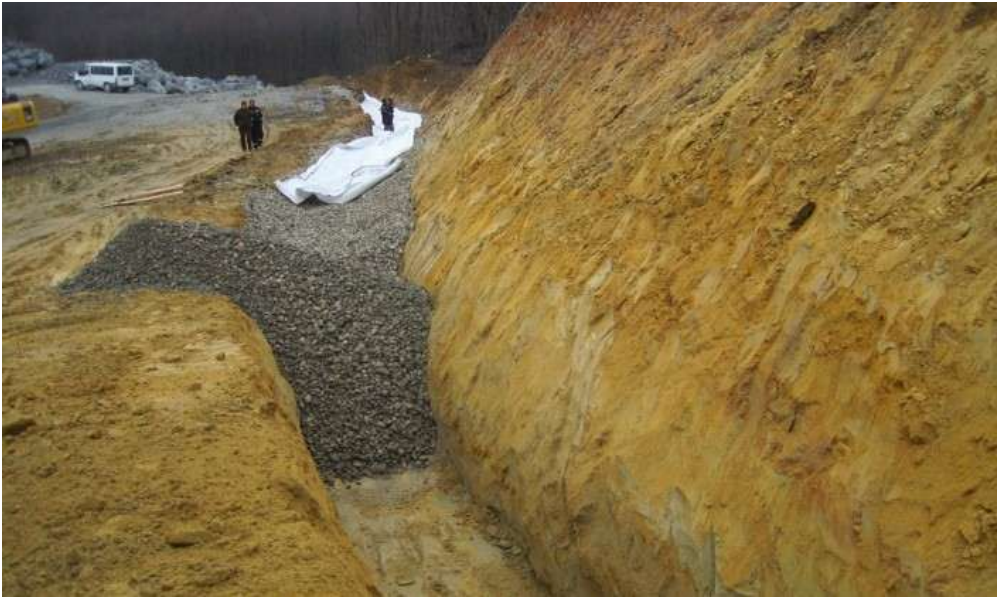
Resim 1: Yeraltı Suyu Drenajı
