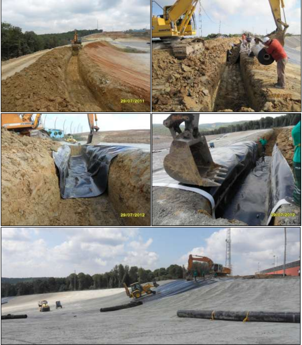
Resim 5: Ankraj Hendeđi ve Jeomembranın Hendeđe Yerleřtirilmesi
