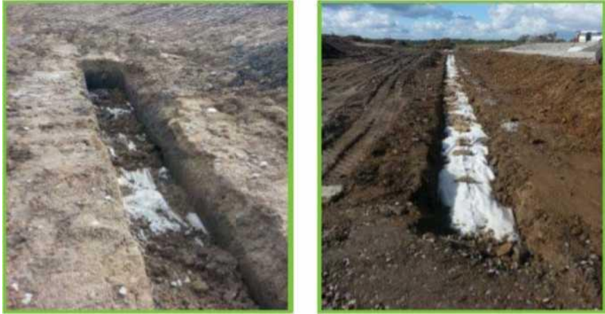
Şekil 31: Yeraltı suyu toplama ağı
