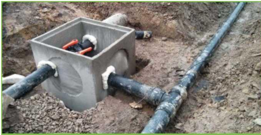
Şekil 32: Kontrol ve bağlantı noktaları
