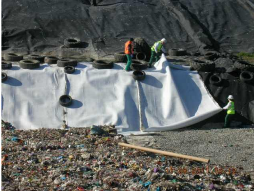
Şekil 52: Birleşik drenaj uygulanması
