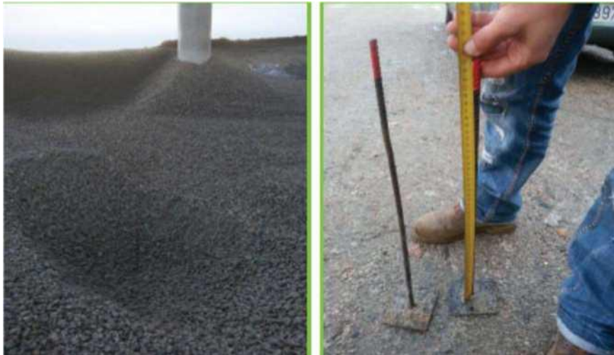
Şekil 42: Çakıl katmanının kalınlığı
