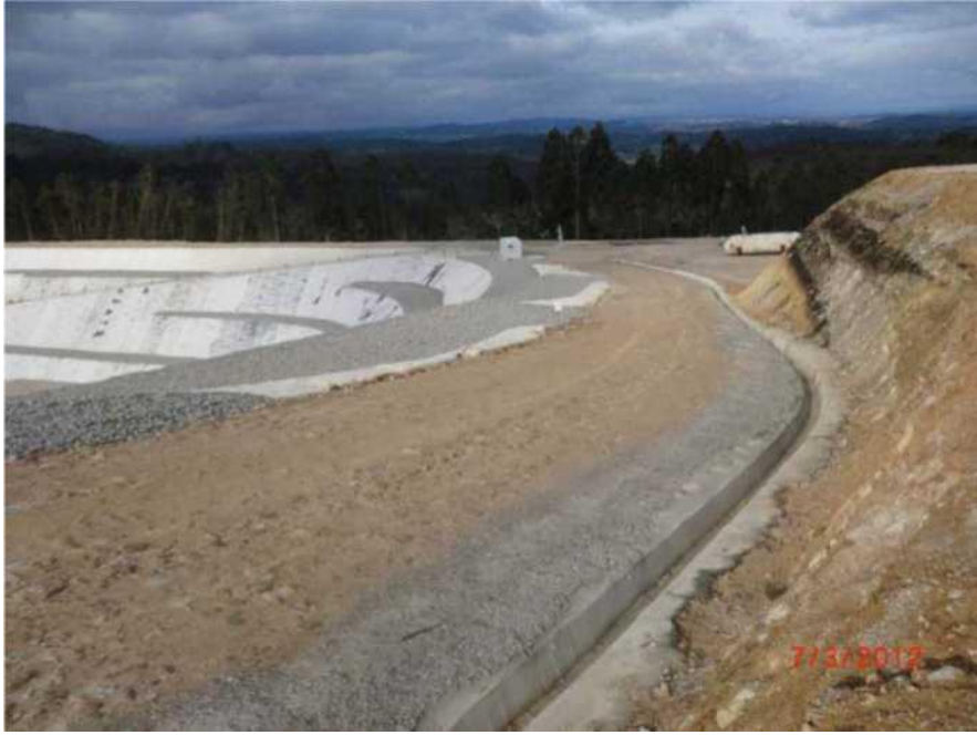
Şekil 49: Yağmur suyu için hendek çevre uzunluğu
