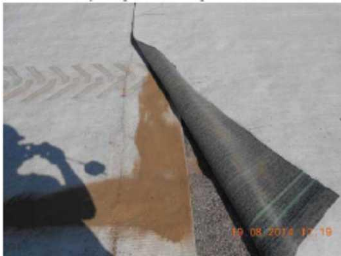
Şekil 39: Jeosentetik kil katmanları
