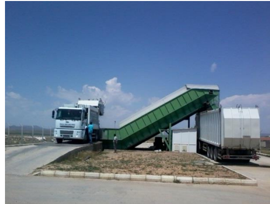
Kulu Transfer İstasyonu
