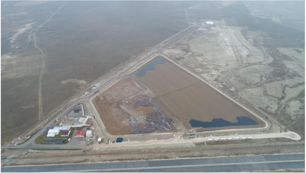
Konya Katı Atık Düzenli Depolama Sahası İnşaatı
