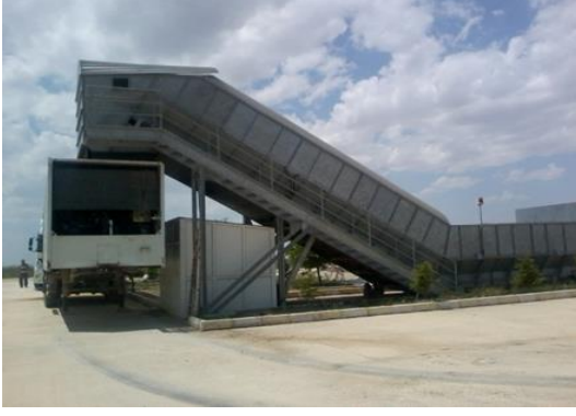
Altınekin Transfer İstasyonu
