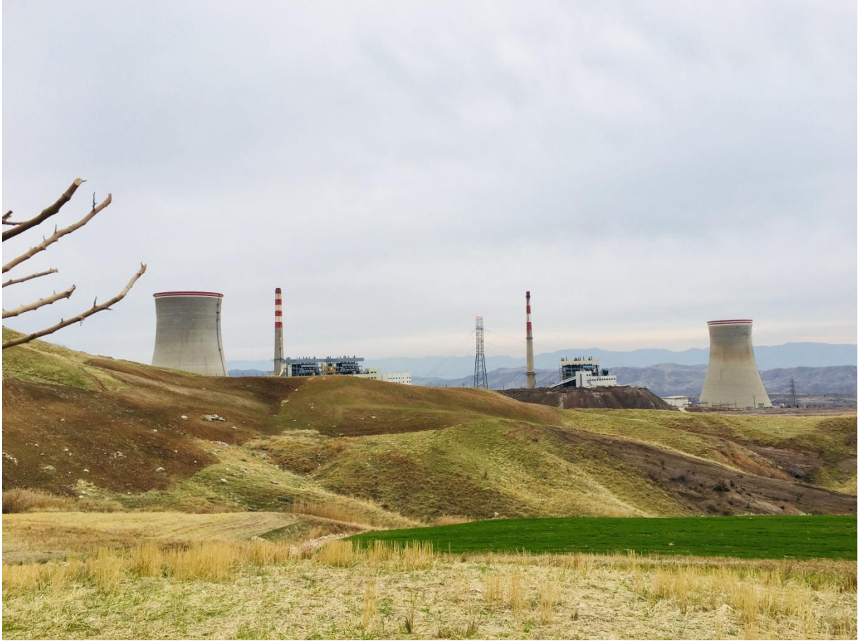
Şekil C.13 – Silopi Elektrik Üretim A.Ş Termik Santrali (Silopi Elektrik Üretim A.Ş. Mayıs 2018)
