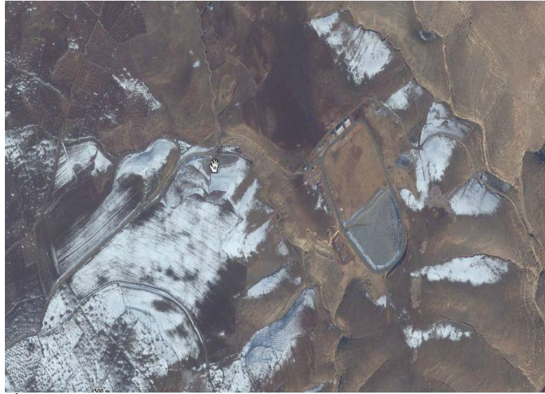
Resim B.1- Siirt İli Katı Atık Düzenli Depolama Tesisi (Siirt Belediye Başkanlığı, 2017)
