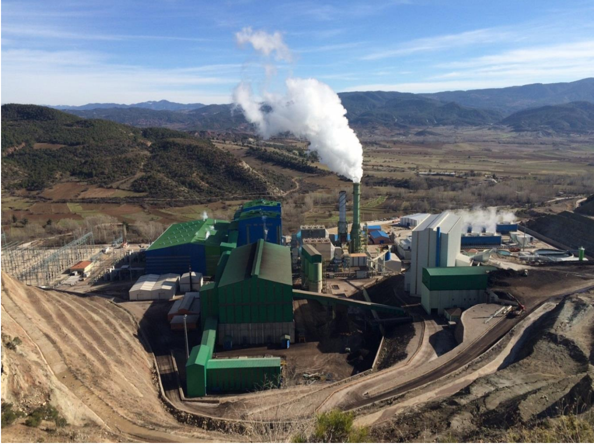
Şekil C.19 – Bolu Göynük Termik Santrali
