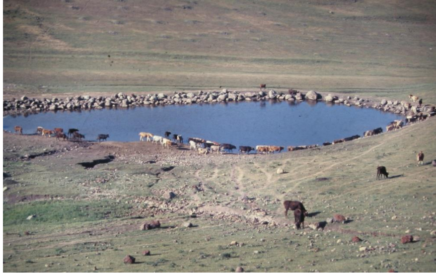
Köy Hizmetleri İl Müdürlüğünce Tesis Edilen Hayvan İçme Suyu Göleti
