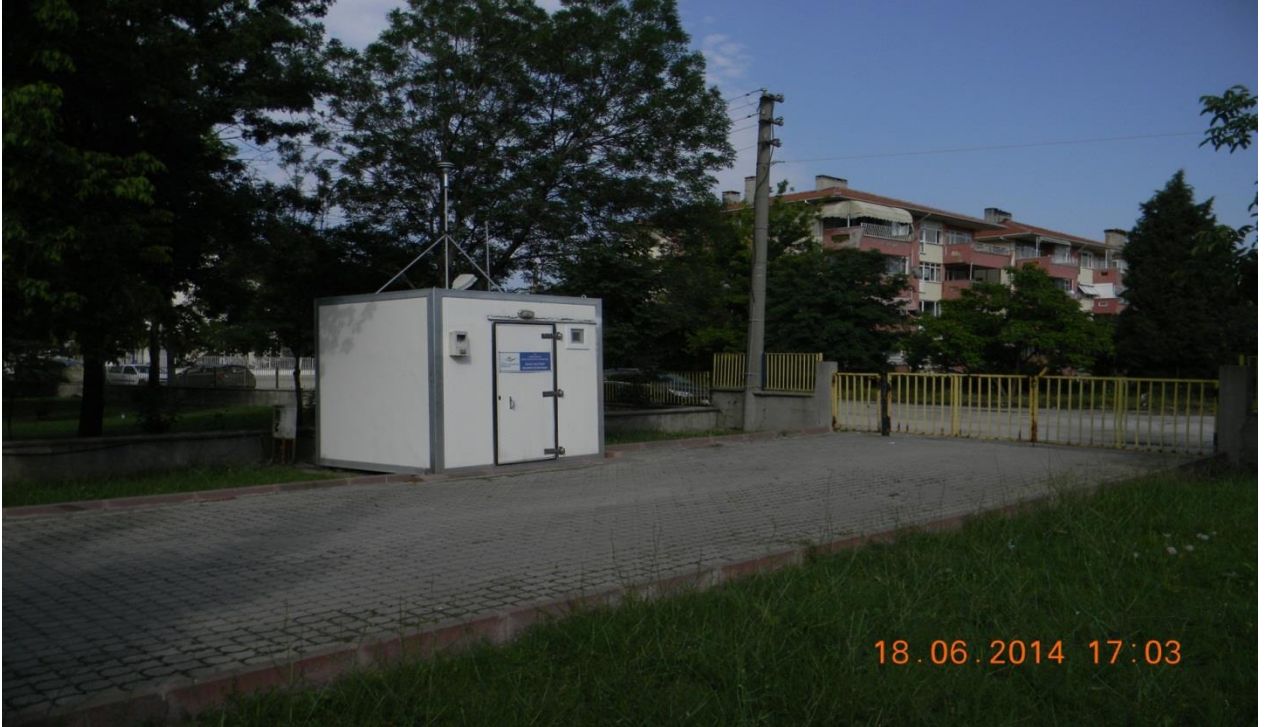
Resim A.1 - Edirne Merkez Hava Kalitesi İzleme İstasyonu
