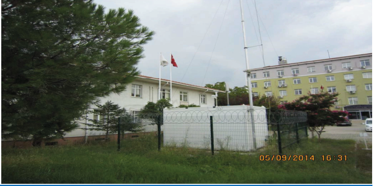
Resim A-2: Çanakkale Çan İlçesi Hava Kalitesi İzleme İstasyonu
