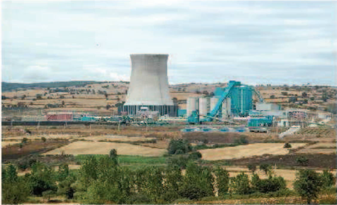
Resim C.1 – 18 Mart Çan Termik Santrali
