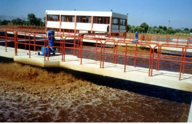
Fotoğraf B. 3- - Salça Fabrikası Arıtma Tesisi
