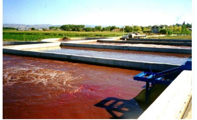
Fotoğraf B. 4 Salça Fabrikası Arıtma Tesisi
