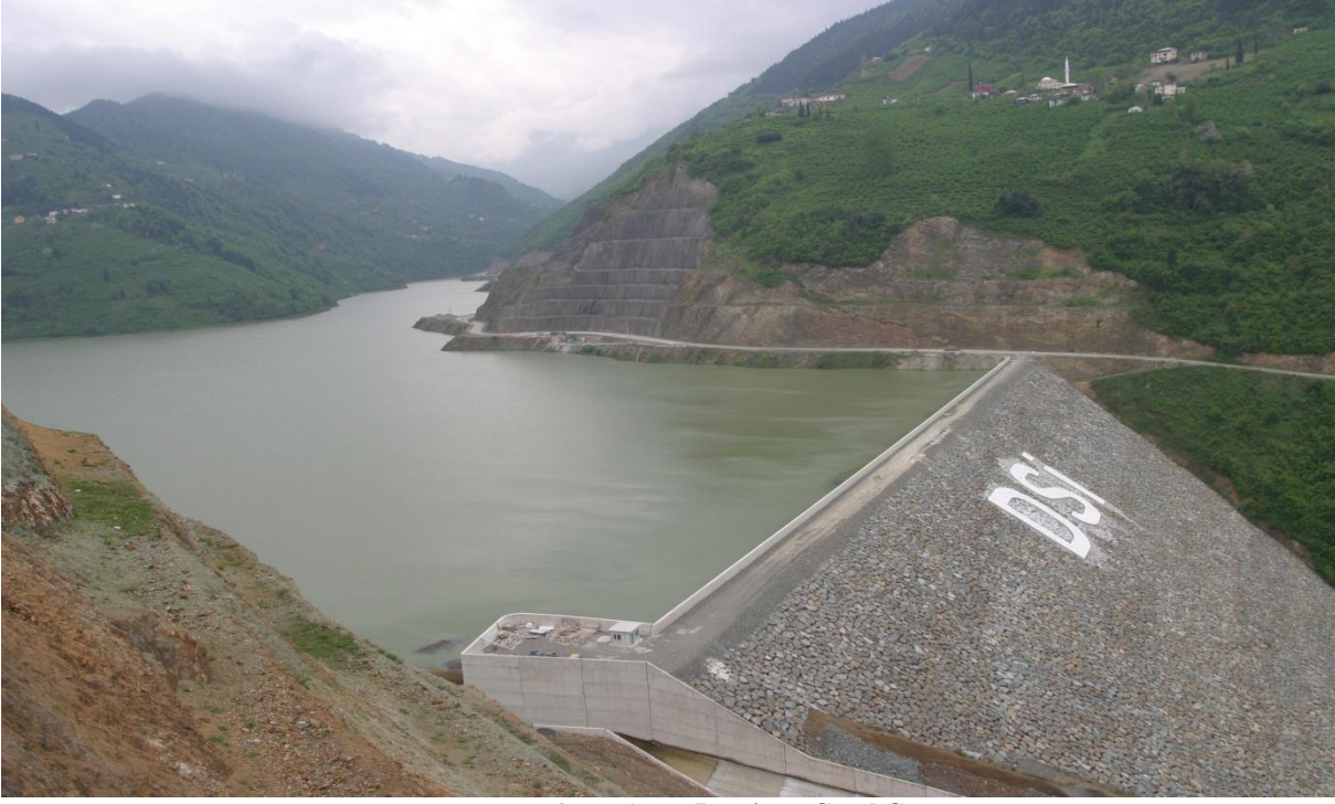
Resim 1: Atasu Barajının Genel Görünümü
