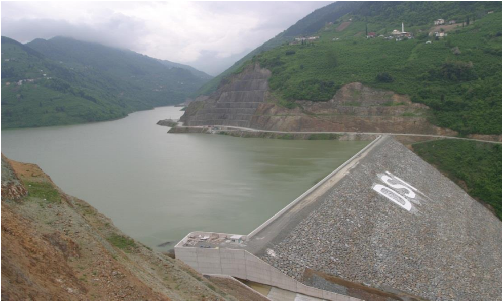
Fotograf 1: Atasu Barajının Genel Görünümü
