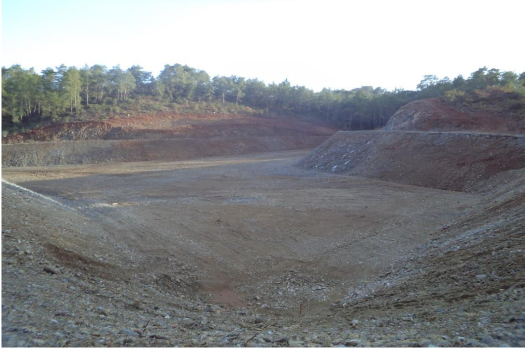
Fotoğraf; 2013 yılı Ortaca Katı Atık Düzenli Depolama Tesisi
