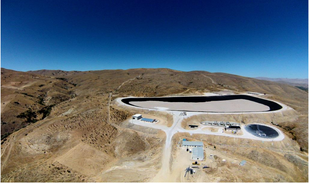
Resim C.1- İlimiz Katı Atık Bertaraf ve Düzenli Depolama Tesisi İnşaatından Görüntüler
