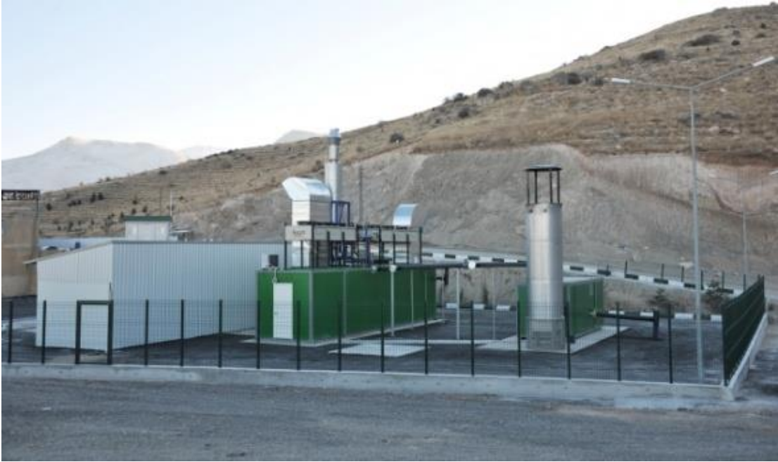
Resim C.2-Mwm Tcg 2020 V12 Biyogaz Motoru Ve Booster Ünitesi
