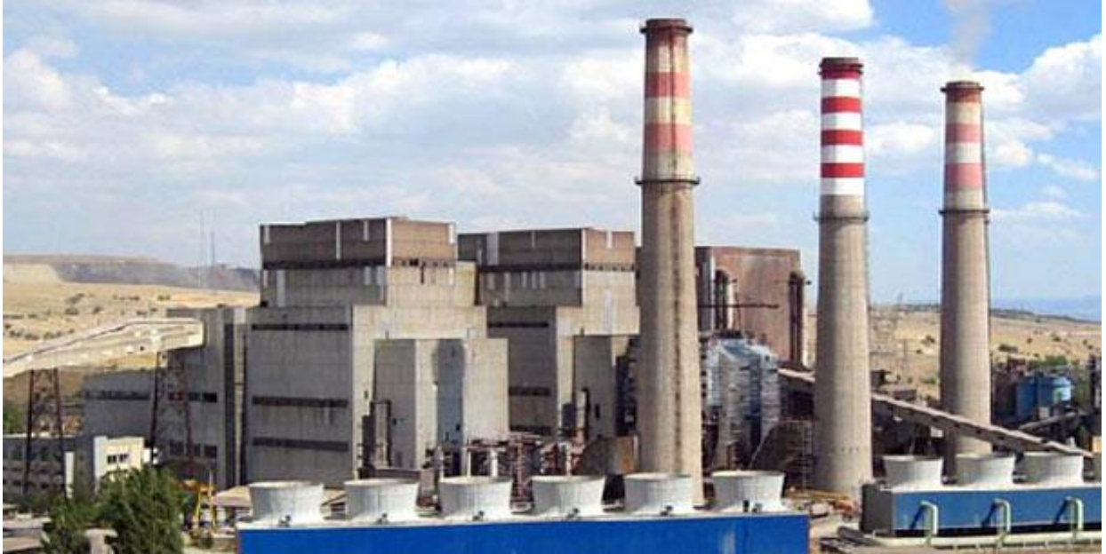
Resim C.2- Kütahya ÇEÜAŞ Termik Santralleri Fotoğrafi
