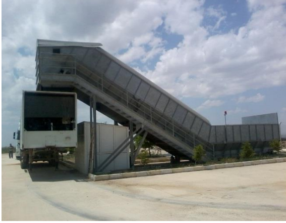
Kulu Transfer İstasyonu
