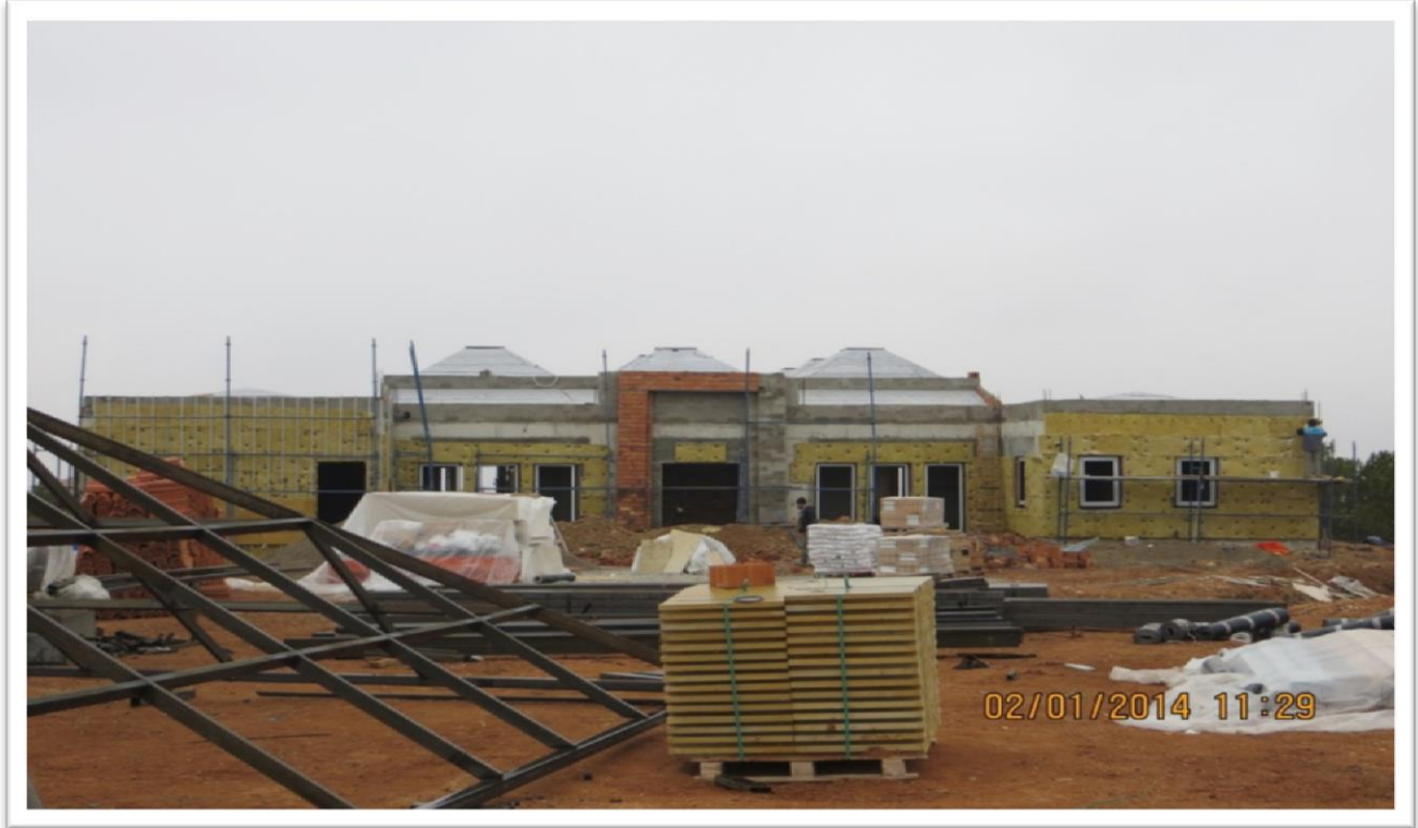
Fotoğraf D.11- Aşıkpaşa Peyzaj Projesi Kapsamında Yapımı Devam Eden Spor Kompleksi
