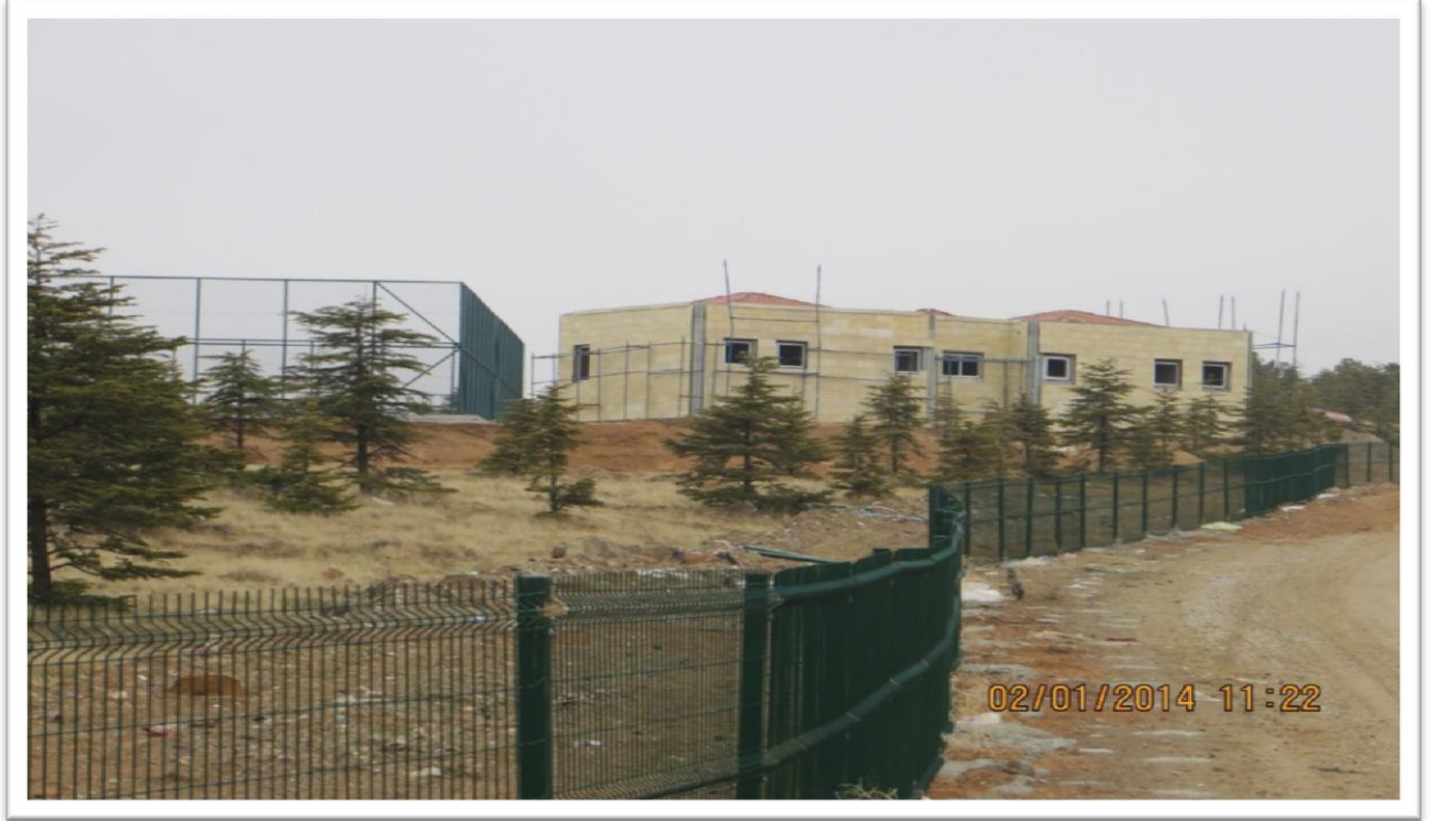
Fotoğraf D.10- Aşıkpaşa Peyzaj Projesi Kapsamında Yapımı Devam Eden Spor Kompleksi
