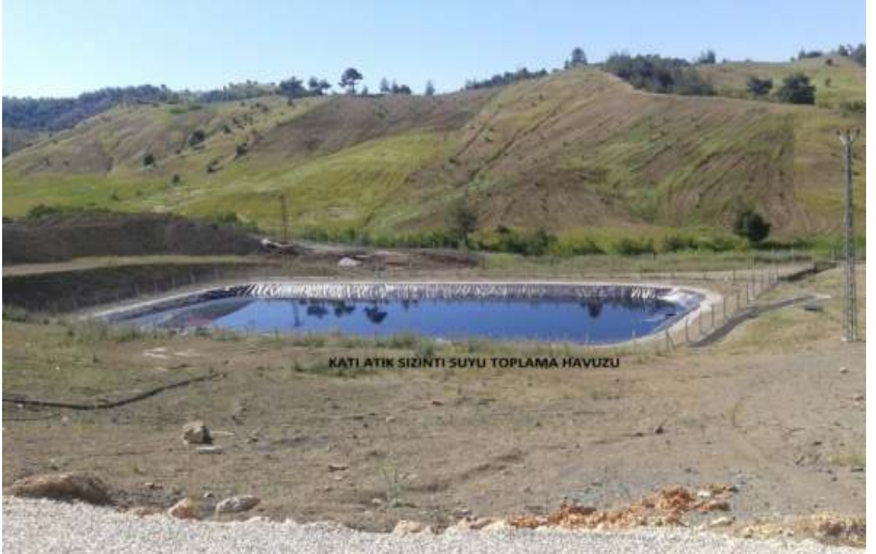
Resim B.2-Katı atık sızıntı suları toplama havuzu
