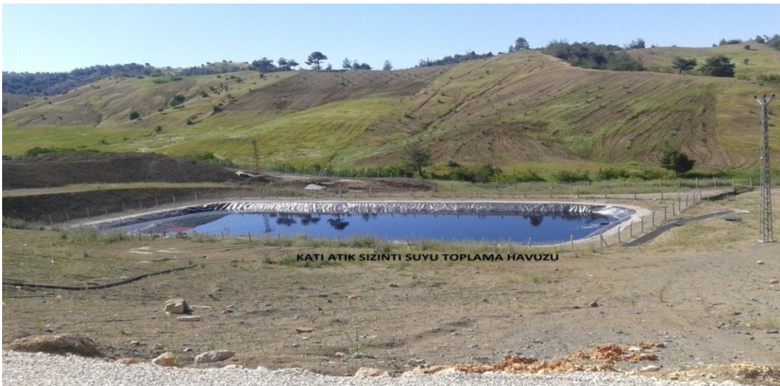
Resim B.2-Katı atık sızıntı suları toplama havuzu
