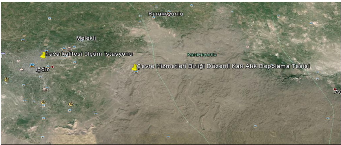
Katı Atık Düzenli Depolama Tesisleri (Google Earth)
