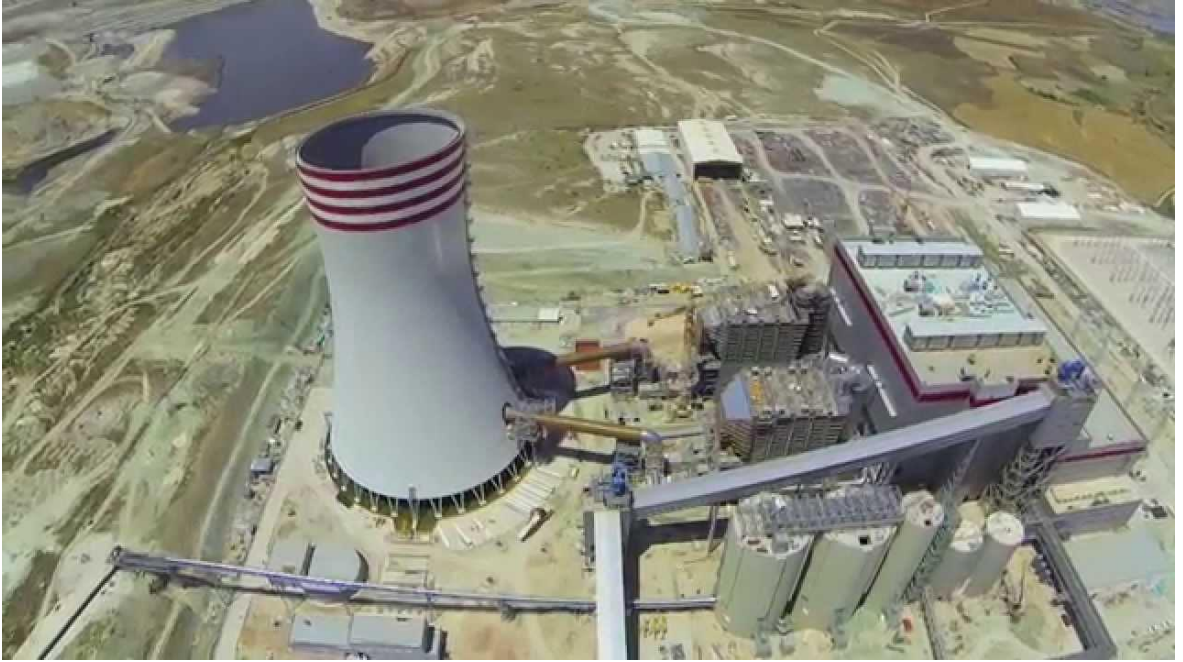
Şekil C.22 – Eskişehir Yunus Emre Yunus Emre Termik Santrali, (2016)
