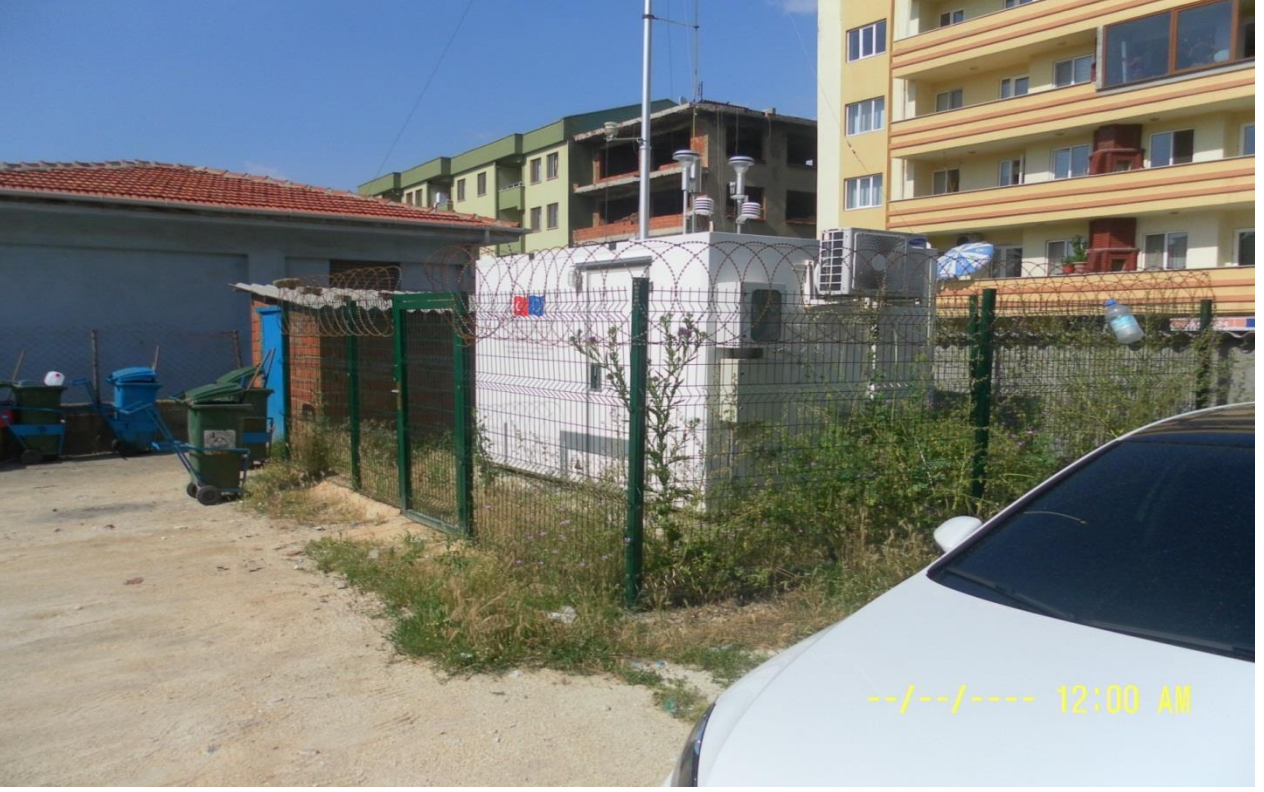
Resim A.3.Edirne Keşan Hava Kalitesi İzleme İstasyonu
