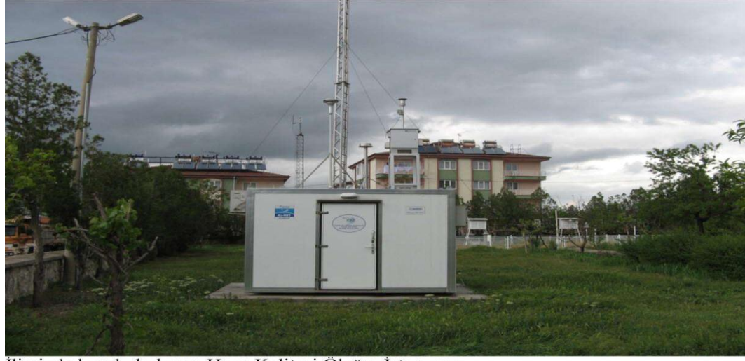
İlimizde kurulu bulunan Hava Kalitesi Ölçüm İstasyonu.
