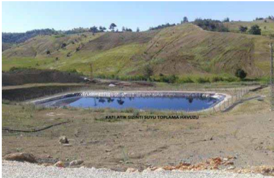
Fotoğraf 95-Katı atık sızıntı suları toplama havuzu
