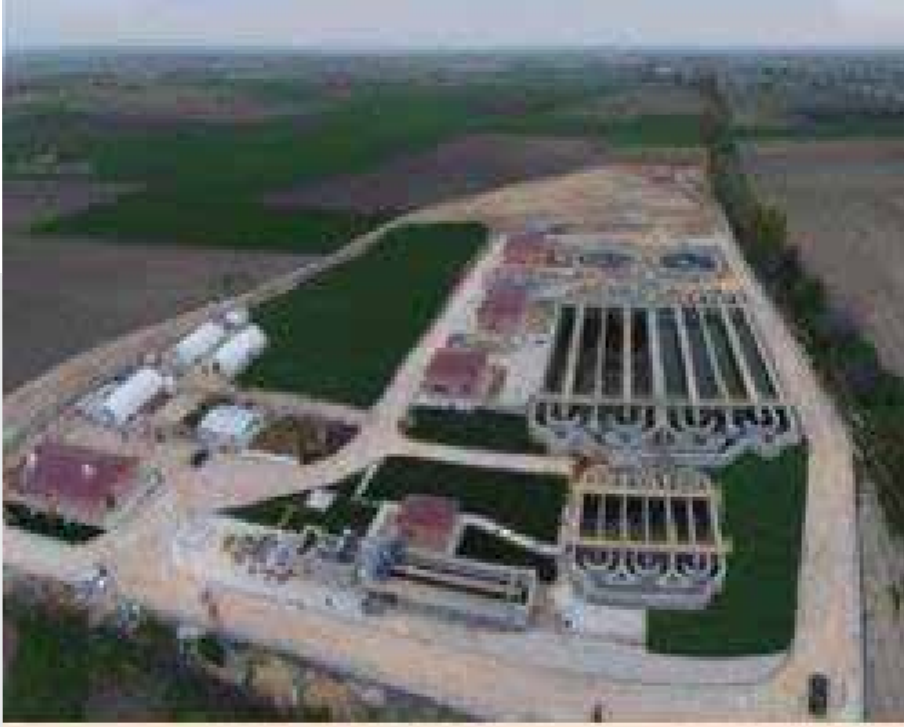
Fotoğraf 60 - Kırklareli Merkez Belediyesi Evsel Atıksu Arıtma Tesisi
