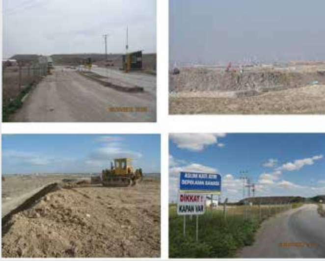
Fotoğraf 80 - Aslım Katı Atık Depolama Sahası
