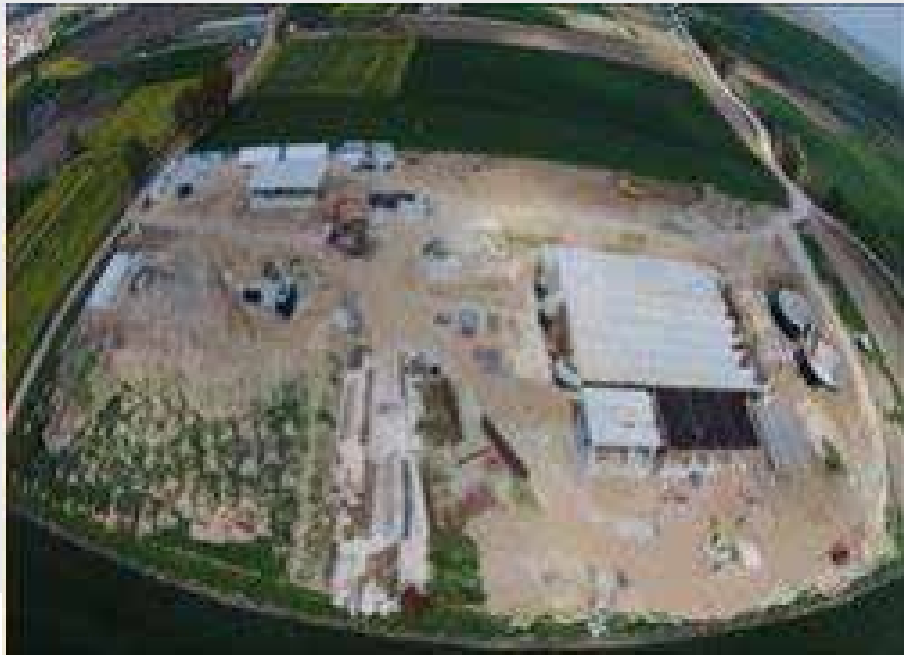
Fotoğraf 61- Babaeski Belediyesi Atıksu Arıtma Tesisi
