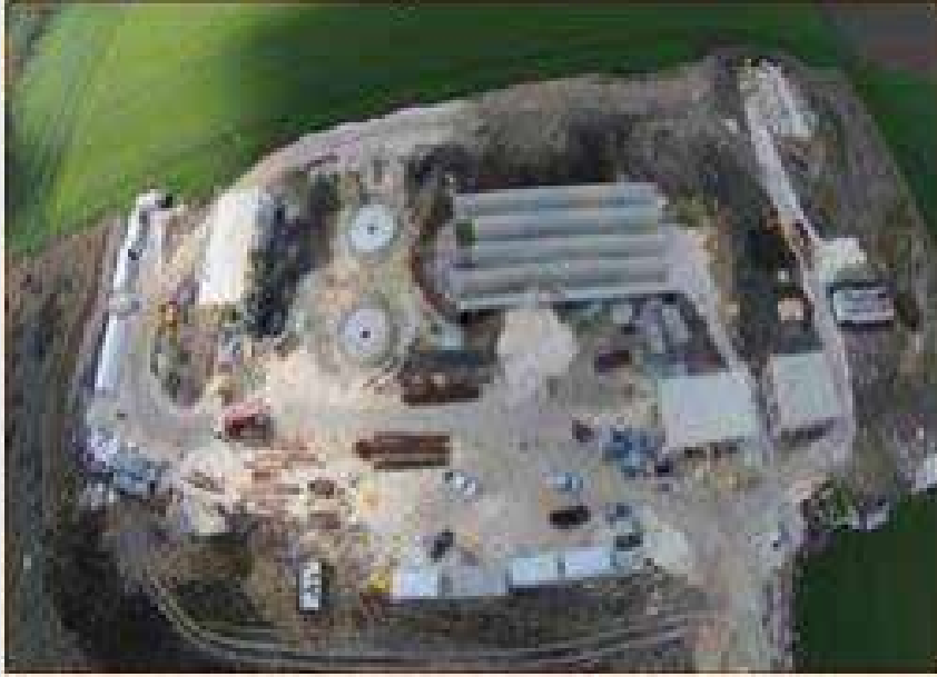
Fotoğraf 62-Pınarhisar Belediyesi Atıksu Arıtma Tesisi
