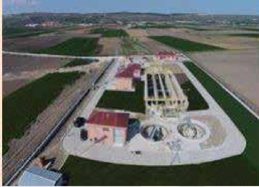
Fotoğraf 63 -Vize Belediyesi Atıksu Arıtma Tesisi
