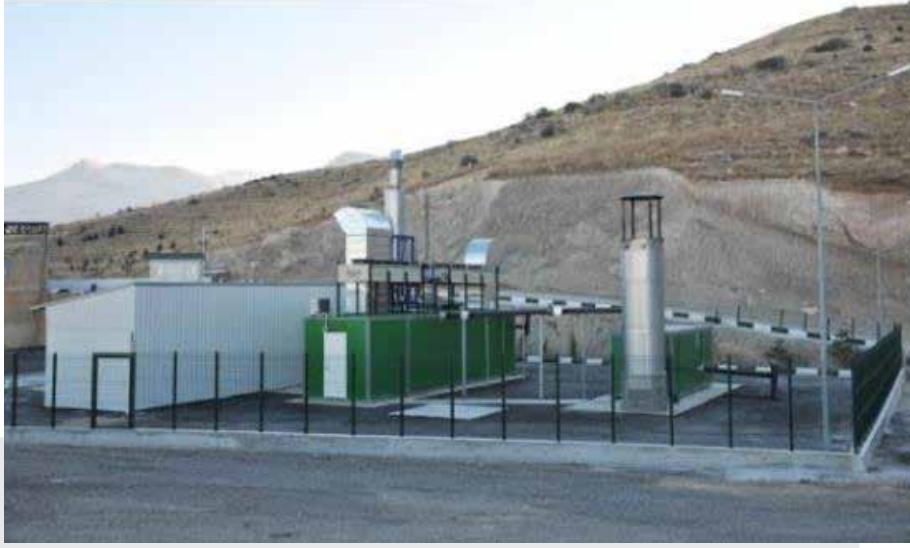
Fotoğraf 86-Mwm Tcg 2020 V12 Biyogaz Motoru Ve Booster Ünitesi
