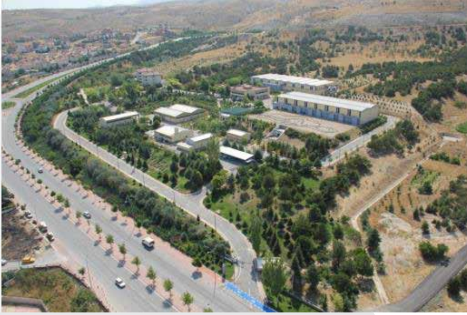
Fotoğraf 78- Konya İçme suyu arıtma tesisi görünümü
