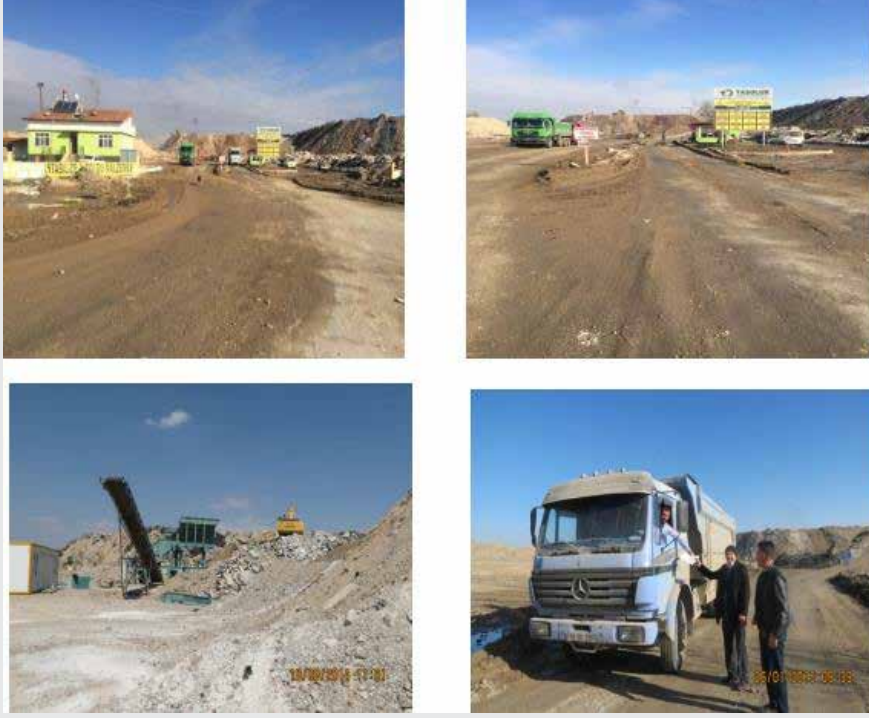
Fotoğraf 81-Hafriyat Toprağı ve İnşaat Yıkıntı Atıkları Depolama Alanı, Kırma Eleme
