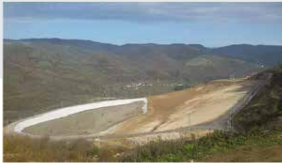
Fotoğraf 172 - Katı Atık Bertaraf Tesisi inşaat çalışmaları (ÇŞİM, 2014) Düzce
