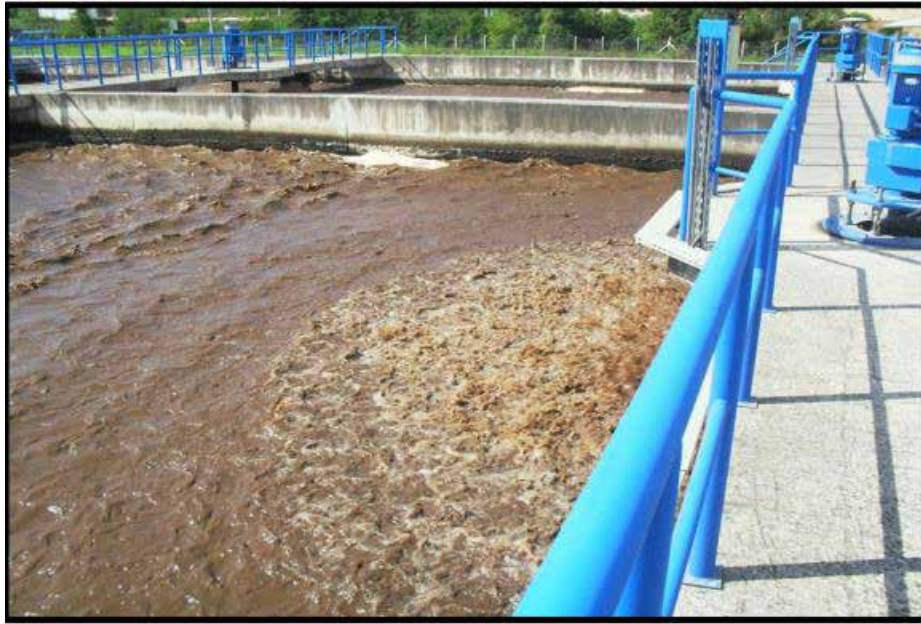
Fotoğraf 103-Ünye Belediyesi Batı Atıksu Arıtma Tesisi Havalandırma Havuzu
