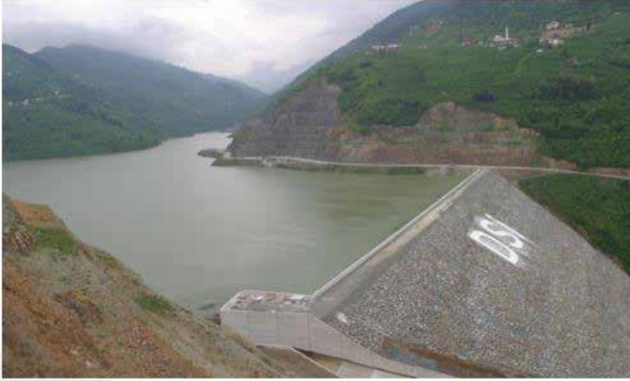
Fotoğraf 140- Atasu Barajının Genel Görünümü
