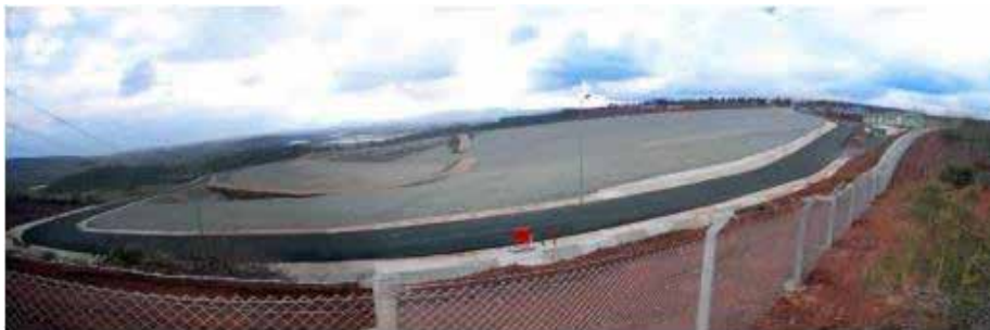
Fotoğraf 118- Düzenli Depolama Sahası Görünümü
