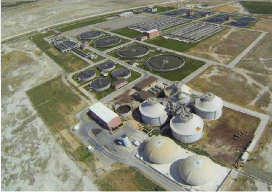
Fotoğraf 79- Konya Kentsel Atıksu Arıtma Tesisi
