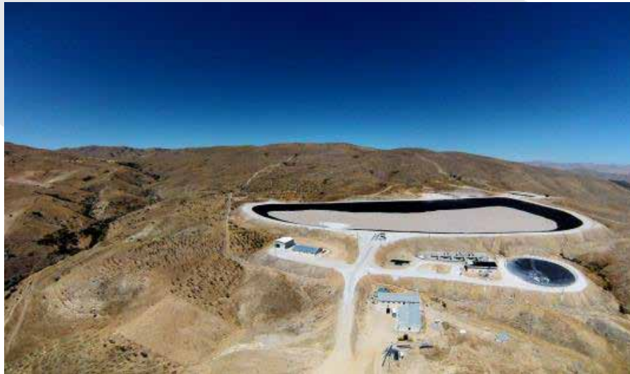
Fotoğraf 85-Malatya Katı Atık Bertaraf ve Düzenli Depolama Tesisi İnşaatından Görüntüler
