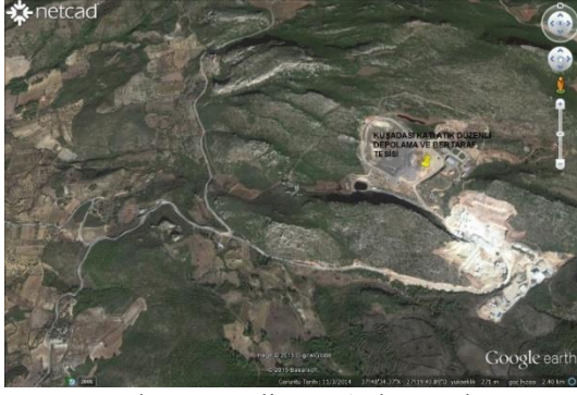
Kuşadası Düzenli Katı Atık Depolama Tesisinden Görünüm
