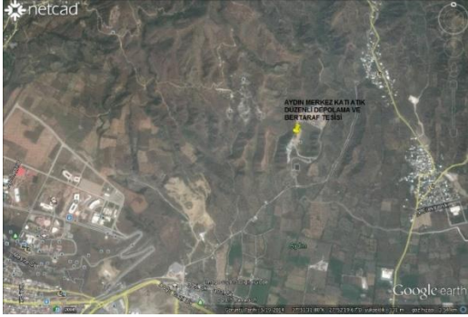
Efeler Merkez Düzenli Katı Atık Depolama Tesisinden Görünüm
