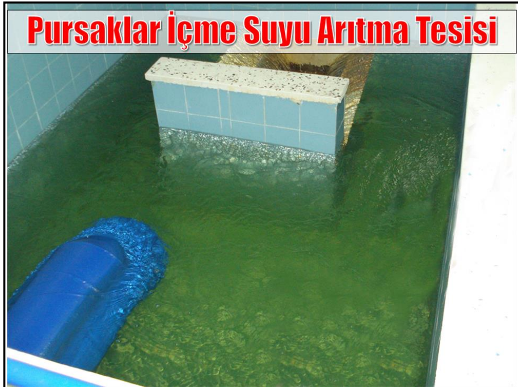
Resim B.4.1.2.4 Pursaklar İçme Suyu Arıtma Tesisi
