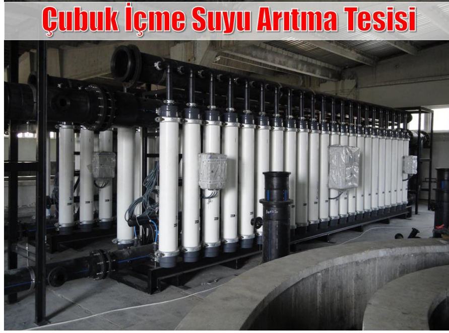
Resim B.4.1.2.6 Çubuk İçme Suyu Arıtma Tesisi
