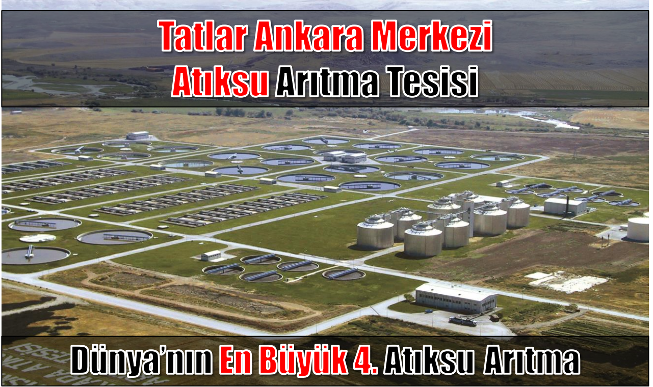
Resim B.5.1.1 Tatlar Atıksu Arıtma Tesisi
