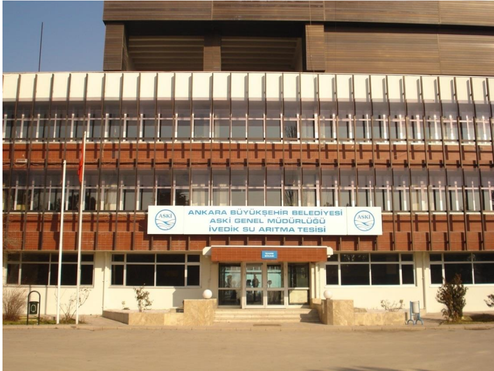
Resim B.4.1.2.1 İvedik İçme Suyu Arıtma Tesisi
