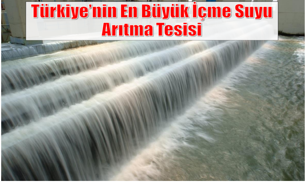
Resim B.4.1.2.2 İvedik İçme Suyu Arıtma Tesisi
