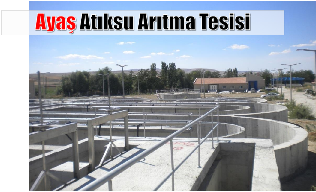
Resim B.5.1.5 Ayaş Atıksu Arıtma Tesisi
