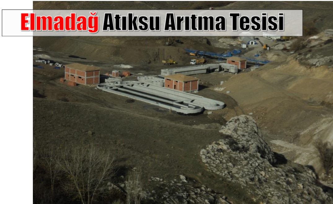
Resim B.5.1.7 Elmadağ Atıksu Arıtma Tesisi
