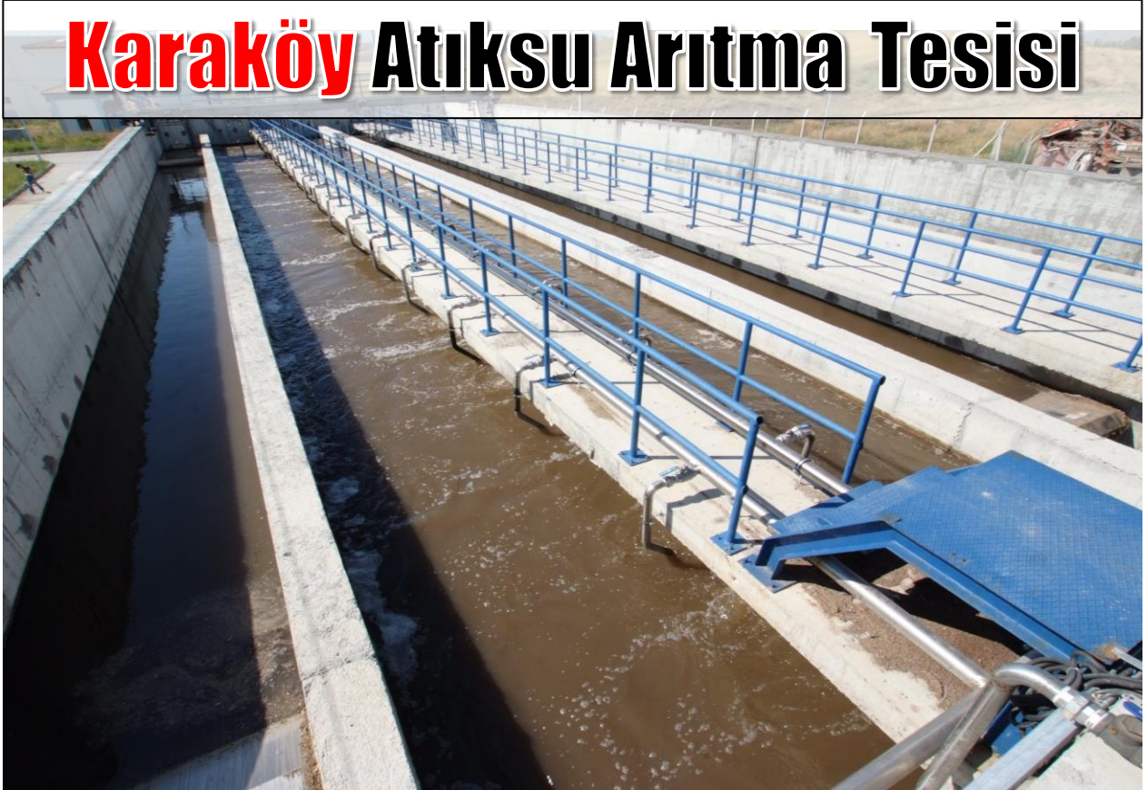
Resim B.5.1.3 Karaköy Atıksu Arıtma Tesisi
