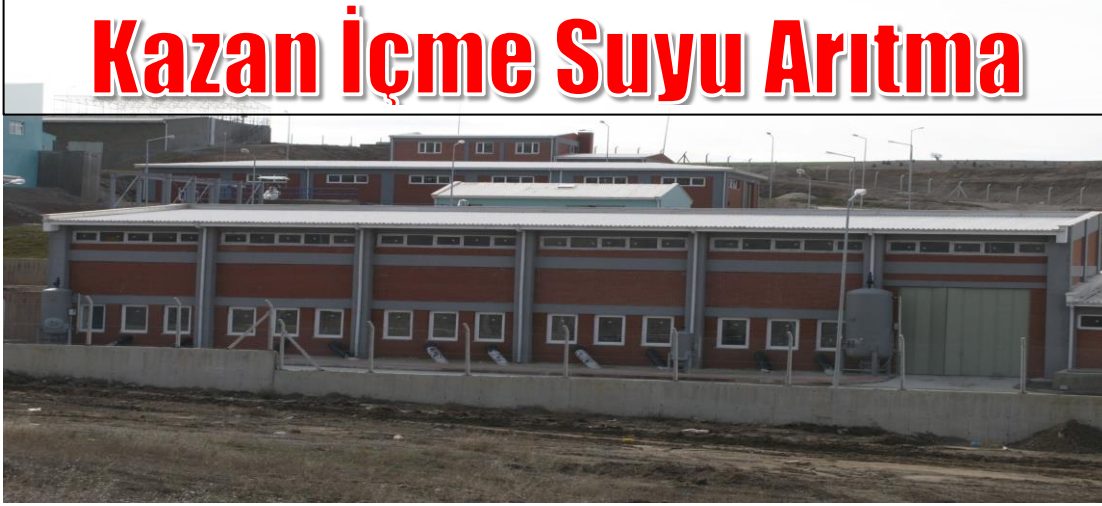
Resim B.4.1.2.5 Kazan İçme Suyu Arıtma Tesisi
