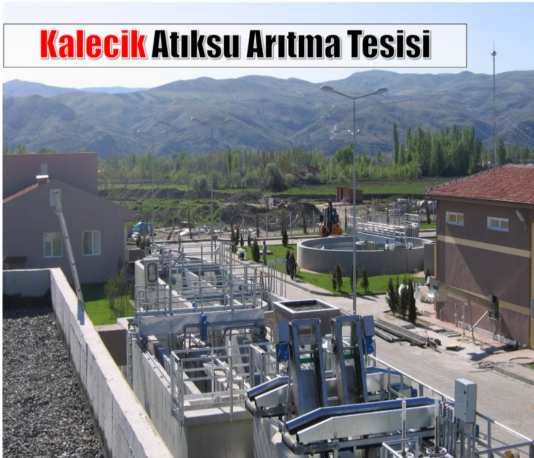
Resim B.5.1.4 Kalecik Atıksu Arıtma Tesisi
