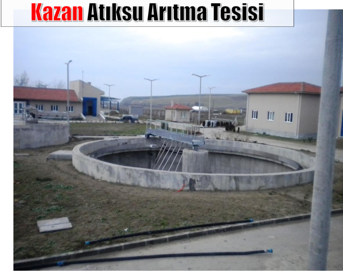
Resim B.5.1.6 Kazan Atıksu Arıtma Tesisi
