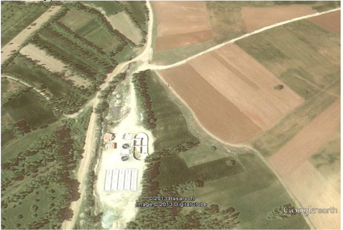
Düzağaç Atıksu Arıtma Tesisi
