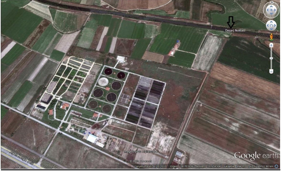
Afyonkarahisar Atıksu Arıtma Tesisi
