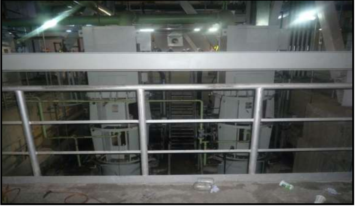
Şekil V.2.1.7. Kondens Pompaları
