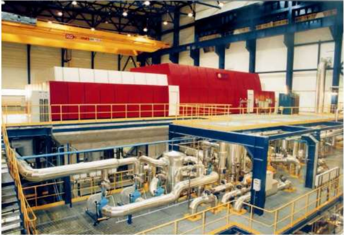
Şekil V.2.1.4. Türbin Jeneratörü Yerleşimi
