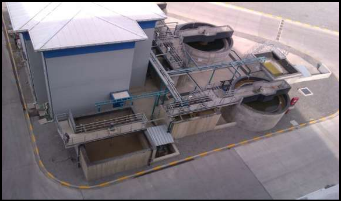
Şekil V.2.1.18. BGD Atık Su Arıtma Tesisi
