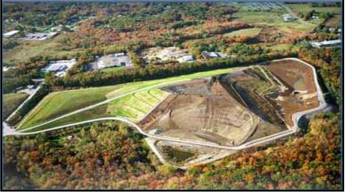
Şekil II.5.2. Shrewsbury Kül Depolama Sahası'ndan Görünüm
