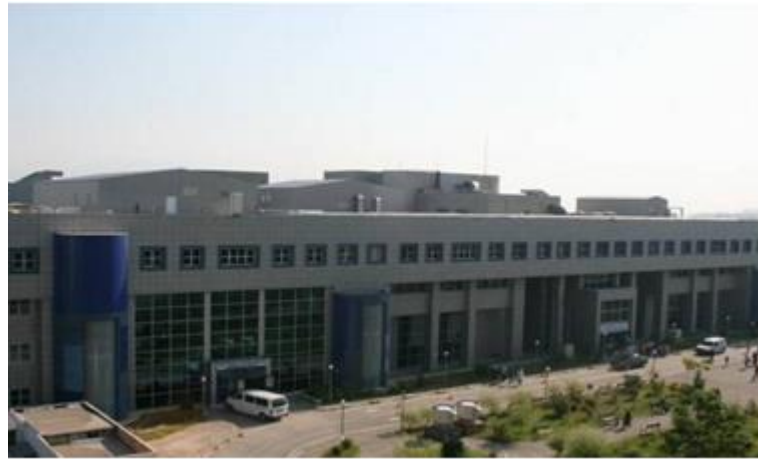
Şekil 5.8. Bursa Şevket Yılmaz Devlet Hastanesi Dış Görünüşü
