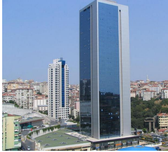
Şekil 1.2. Polat Tower Binasının Dıştan Görünüşü
