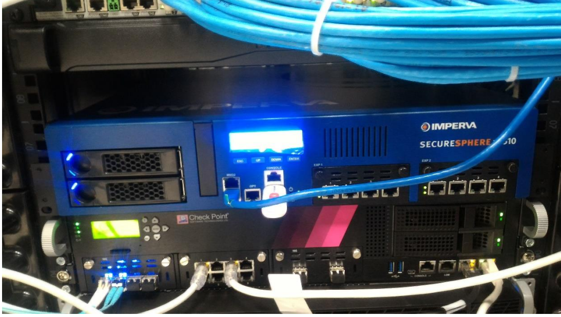
Şekil 10. Veritabanı Güvenlik Duvarı kabin ekran görüntüsü
