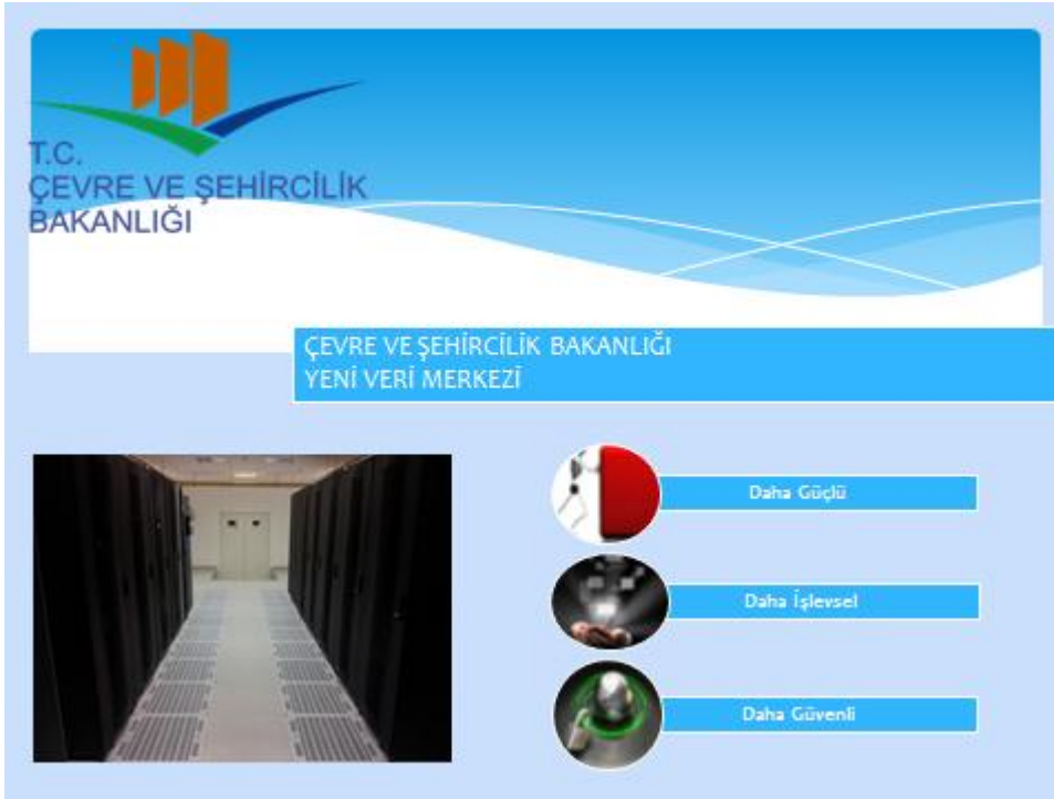
Şekil 7. ÇŞB Yeni Veri Merkezi
