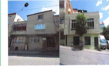
Şekil-12. Çarpık ve İnşaat Kalitesi Düşük Yapılar
