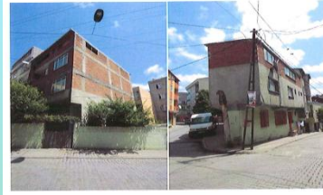
Şekil-11. Proje Alanlarındaki Mevcut Yapılar
