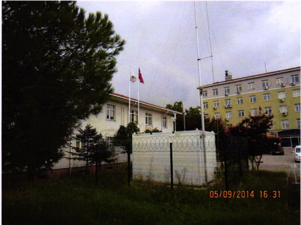
Şekil 12- Çanakkale Çan İlçesi Hava Kalitesi İzleme İstasyonu
