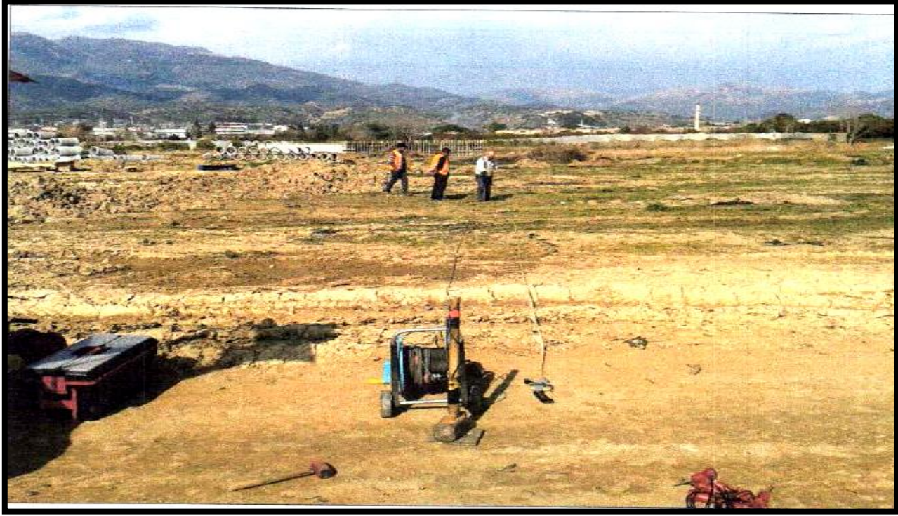
Şekil 13: Proje Sahası Görünümü
