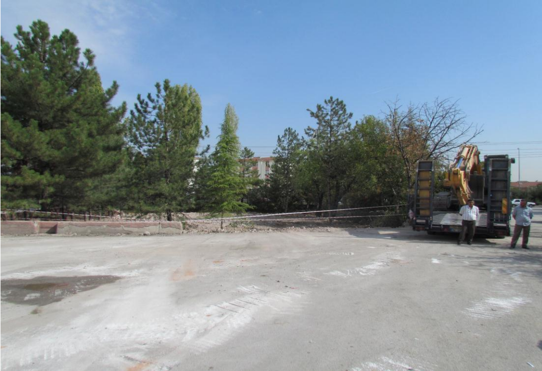
Keçiören İlçemiz sınırlarında yer alan 1 blok (8 daire) yıkım işi gerçekleştirilmiştir
