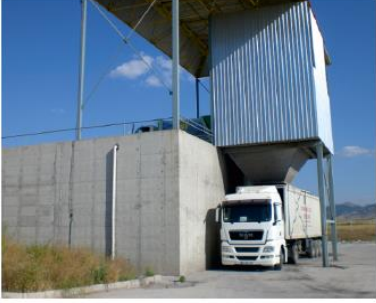
Katı Atık Transfer İstasyonu
