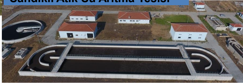
Sandıklı Atık Su Arıtma Tesisi
