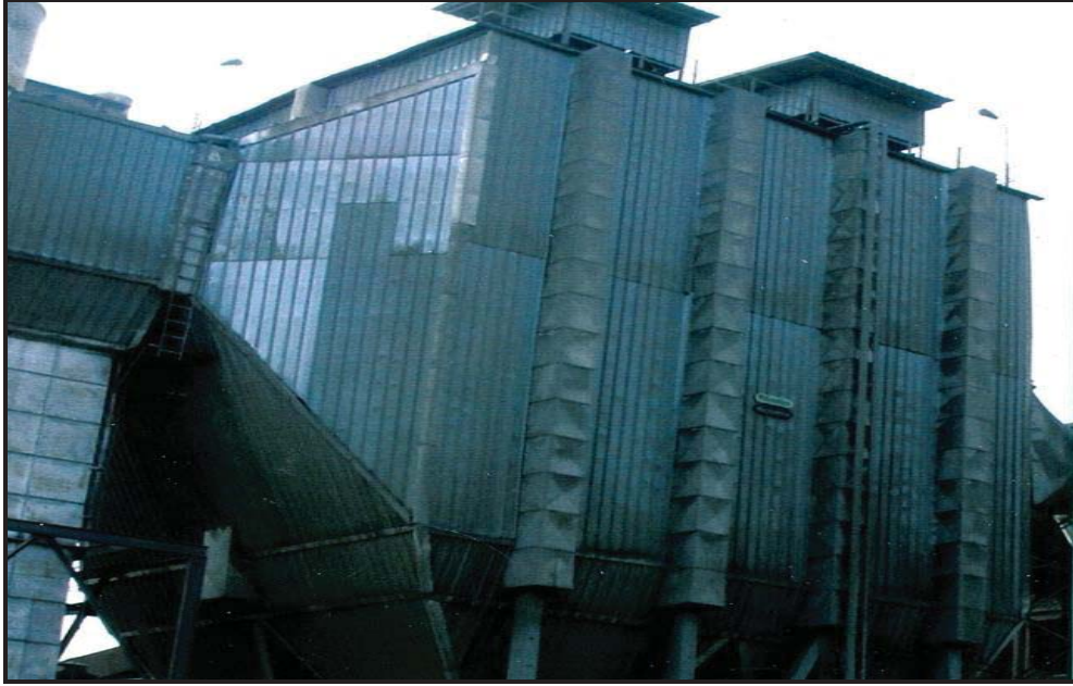
Şekil 13: Elektrostatik Filtre Temsili Fotoğrafi
