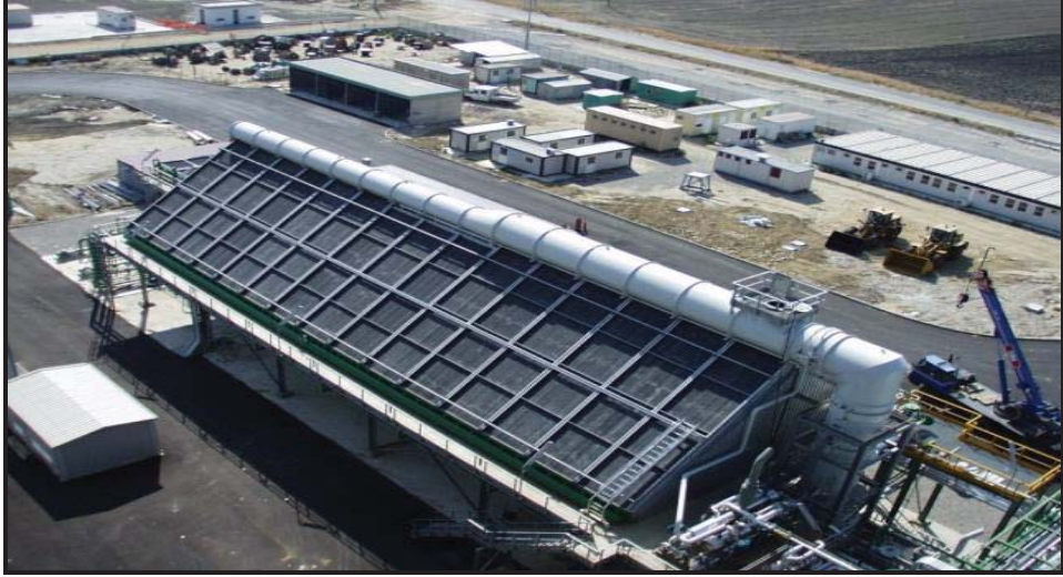
Şekil 14: Hava Soğutmalı Kondenseler
