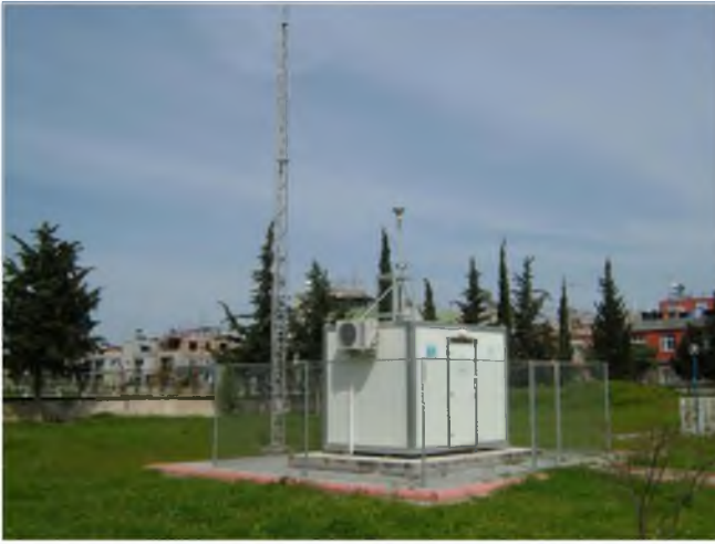
Resim-9:Meteoroloji Hava Kalitesi İzleme İstasyonu
