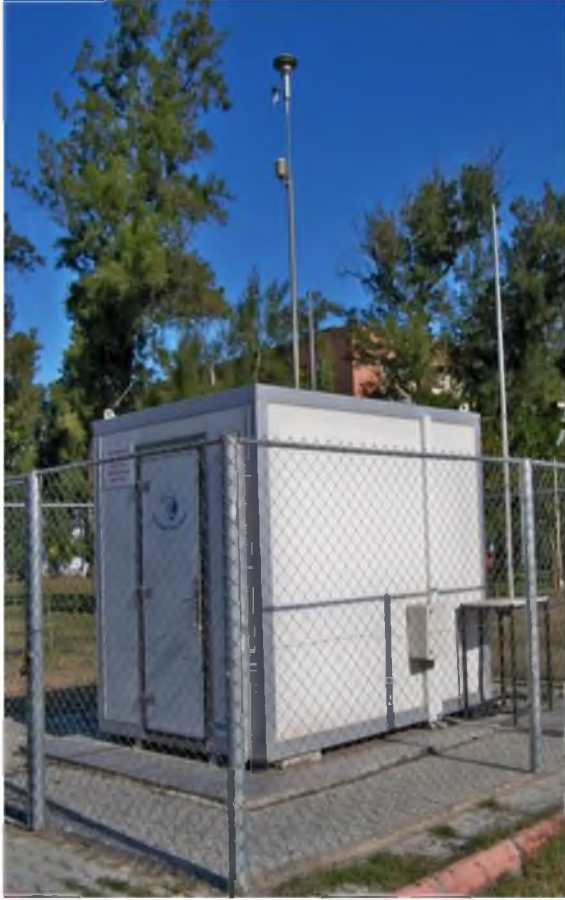
Resim-7: Valilik Hava Kalitesi İzleme İstasyonu
